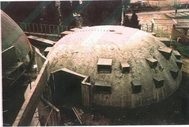
Şekil IV.4. Burhan Felek Küçük Salon - giriş binası dış görünüş (yapım sırasında)
