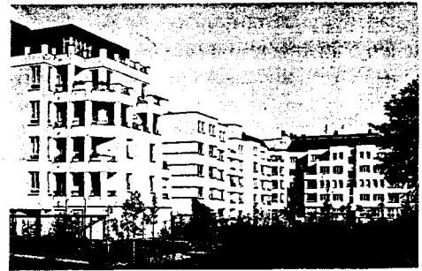
sokaktan ve avlu içinden görünüşü
