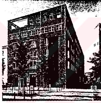
Oranien sokağındaki baş inşaat
