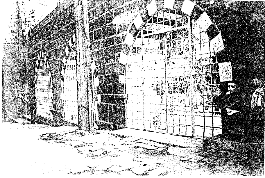
Resim 3.8. Zinciriye Medresesinin kuzeyindeki kemerli balçe duvarı, sokaktan görünüşü
