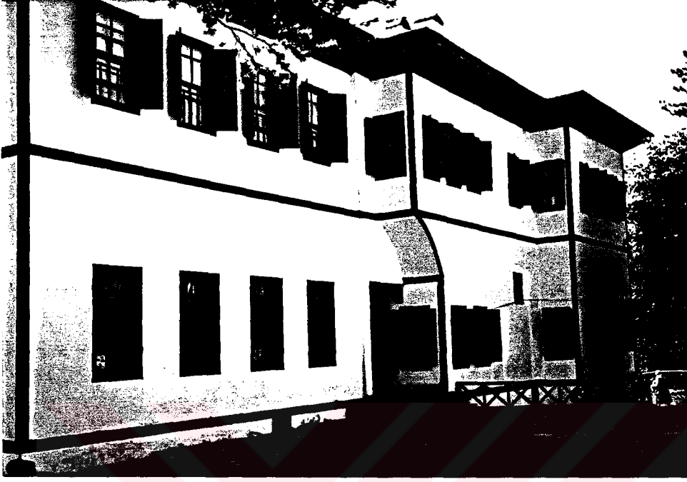
Resim 3.6 Asmazlar Konađı Otelinin Dış Cephesinden Bir Görünüş
