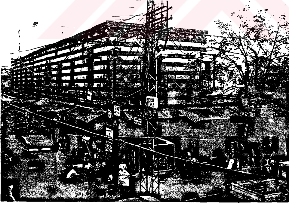
Resim 5.13 Hasan Paşa Hanı Dış Cephesinden Bir Görünüş
