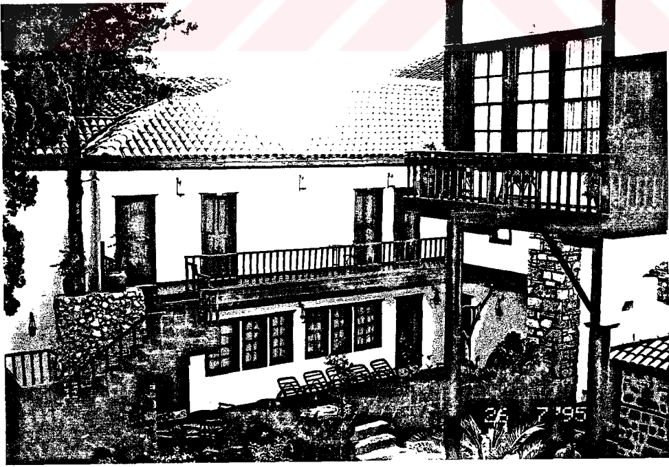
Resim 3.12 Alp Paşa Oteli Avlu Cephesinden Bir Görünüş
