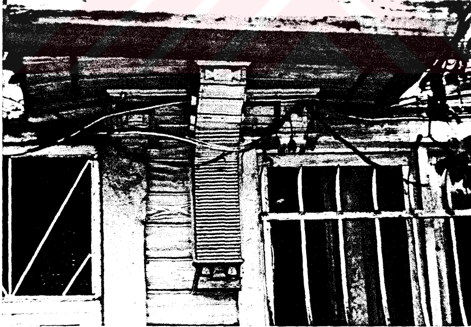
Resim IV.6. Yapının Ahşap Payandasından Bir Görünüş
