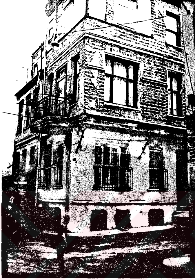
Resim III.19. ıkık Sokak 4 Nolu Kagir Yapının Metal Payanda rneęi
