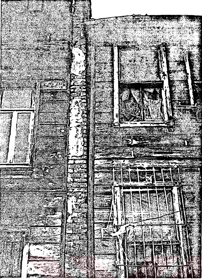
Fotoğraf 4.17. – Fotoğraf 4.18. Yavuz Sinan Mahallesi'ndeki Yapılarda Oturma ve Dönmeler (1996)
