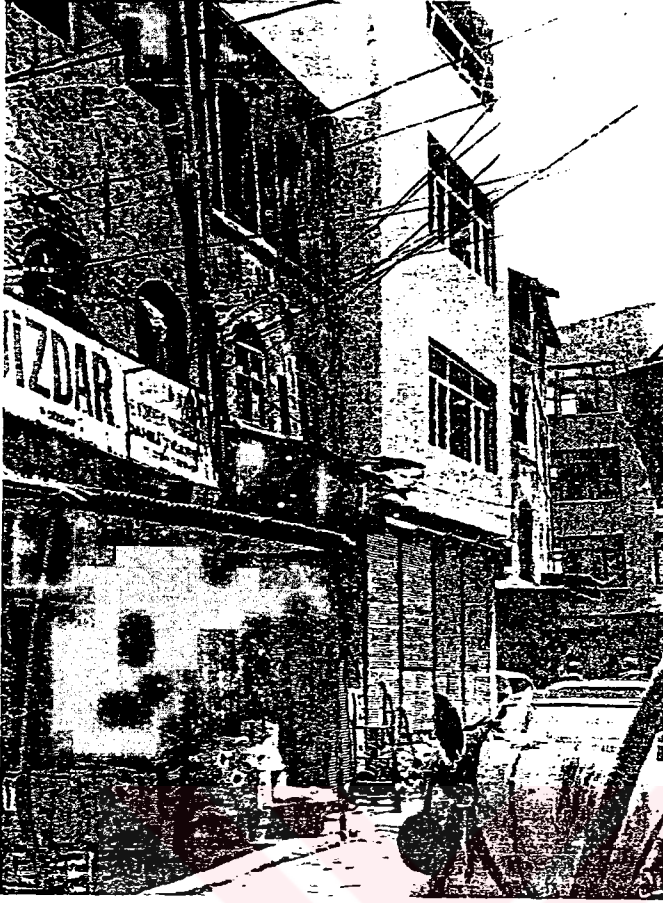
Fotoğraf 4.6.-Fotoğraf 4.7. Eski Yemiş Bölgesi'ndeki Yapılarda Oturma ve Dönmeler (1984)
