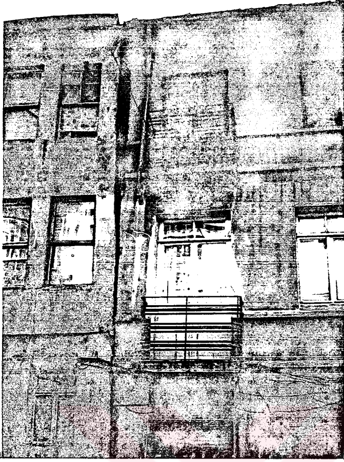
Fotoğraf 4.13.- Fotoğraf 4.14. Yavuz Sinan Mahallesi'ndeki Yapılarda Oturma ve Dönmeler (1996)
