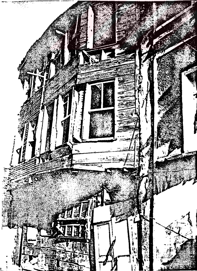
Fotoğraf 4.15.- Fotoğraf 4.16. Yavuz Sinan Mahallesi'ndeki Yapılarda Oturma ve Dönmeler (1996)
