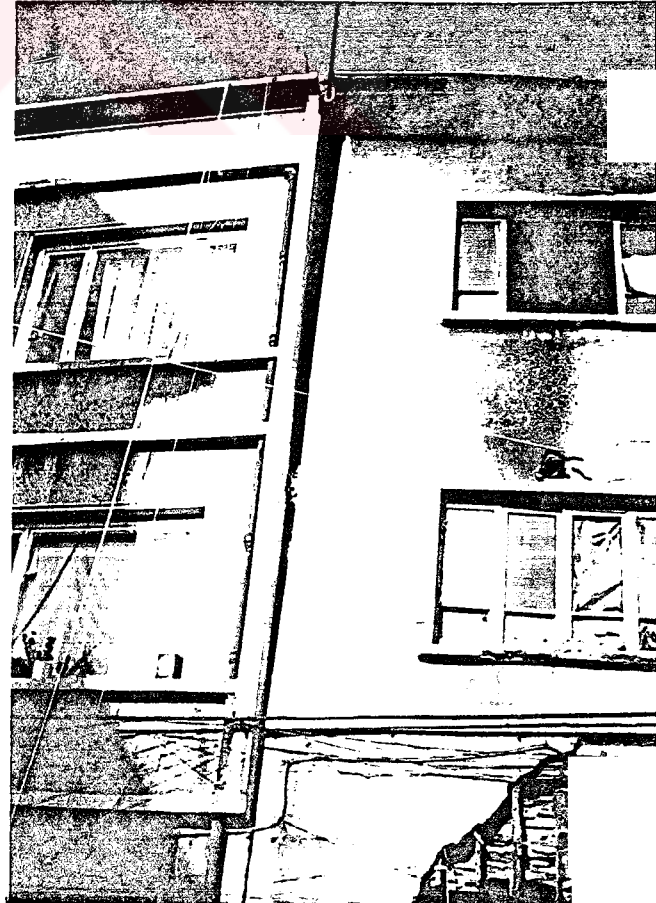
Fotoğraf 4.23. - Fotoğraf 4.24. Yavuz Sinan Mahallesi'ndeki Yapılarda Oturma ve Dönmeler (1996)
