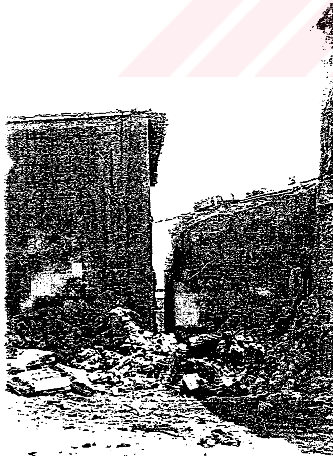
Fotoğraf 4.4.-Fotoğraf 4.5. Eski Yemiş Bölgesi'ndeki Yapılarda Oturma ve Dönmeler (1984)
