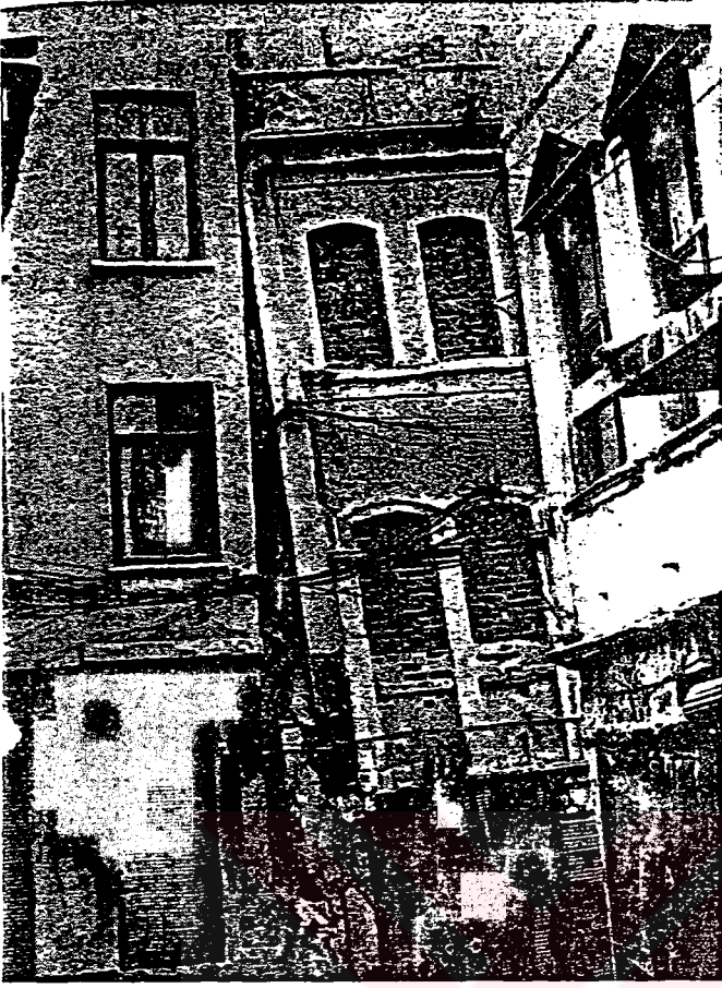
Fotoğraf 4.2.- Fotoğraf 4.3. Eski Yemiş Bölgesi'ndeki Yapılarda Oturma ve Dönmeler (1984)
