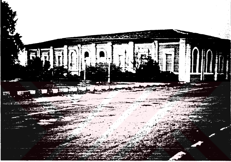
Resim 43 Beş numaralı eşya deposunun kuzeydoğu cephesinin fotoğrafı.
