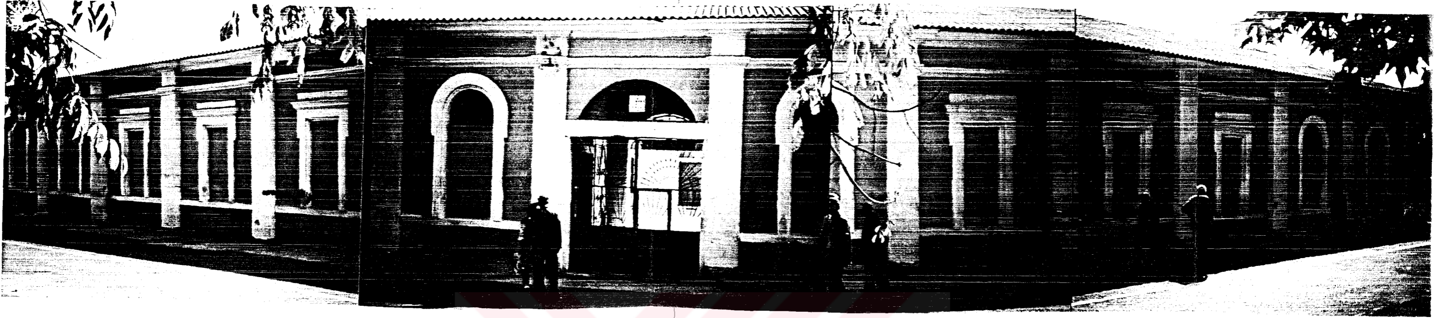
Resim 35 2 numaralı eşya deposunun kuzeybatı cephesinden bir fotoğrafı.
