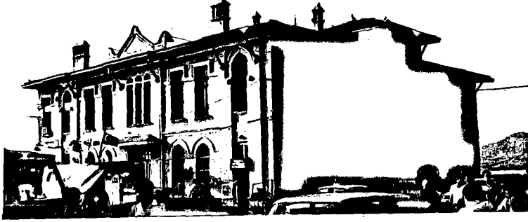
Kantar Polis Karakolu, İzmir. İskelenin cadde üzerindeki kanadında yer alan bu yapıyı Halil Rifat Paşa'nın yaptırdığı kuvvetli ihtimaldir. Yapıların 1884 lerde yapıldığı sanılmaktadır.
