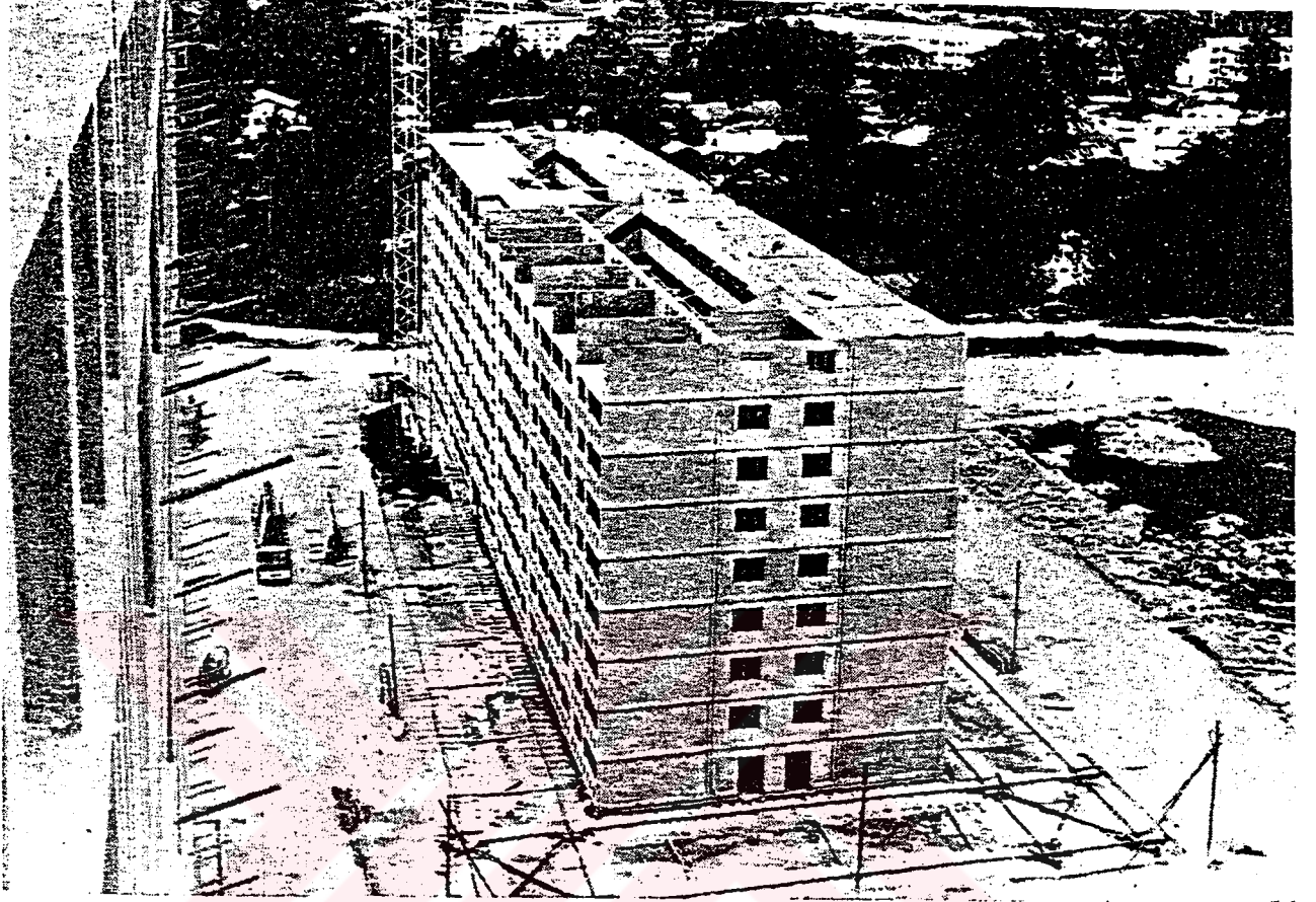
Şekil-3.38. Panel Sistemle Yapılan Bir İnşaatın Görünüşü
