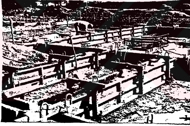
Şekil-2.25. Temel Kalıbı
