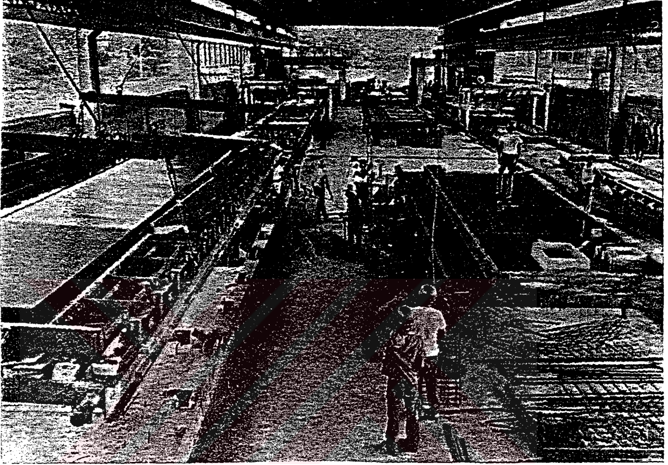
Şekil-3.33. Büyük Beton Panel Üreten Bir Fabrikadan Görünüş
