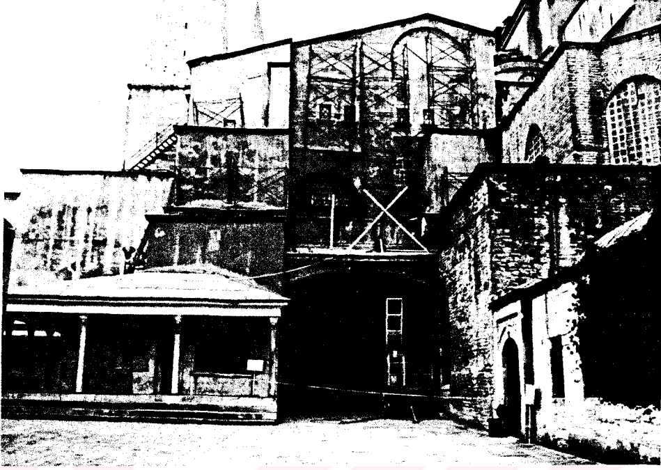
Fotoğraf 3.4. 1994 yılında güneybatı köşesinin onarım öncesi durumu
