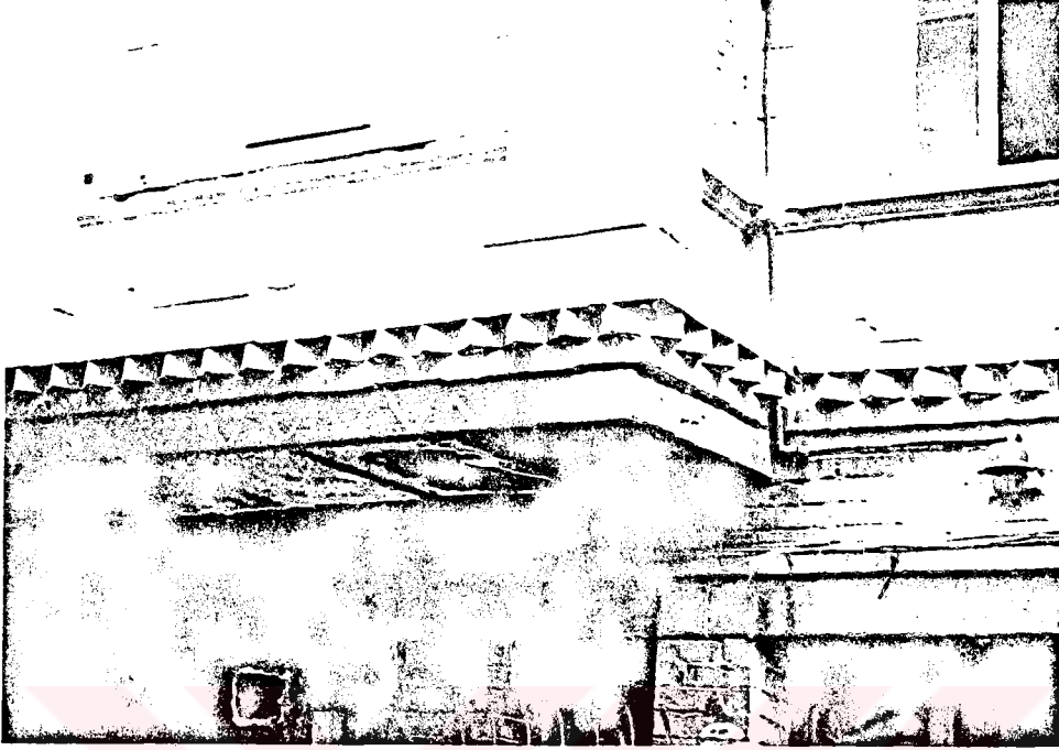
Foto 63 . Tuđlanın cephe ve silmede kullanımı.
