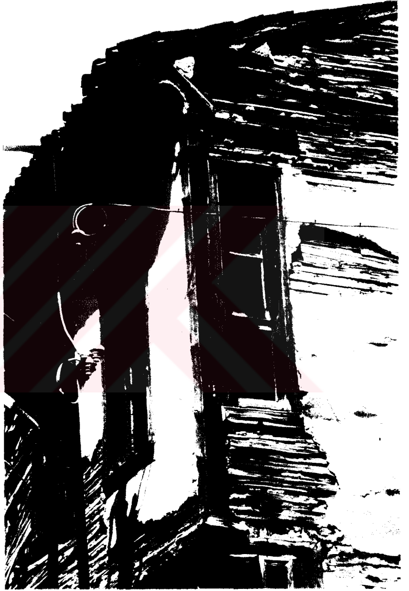
Şekil 92 II.Evin köşe detayı; bağdadi ve dolgu tekniği
