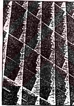
Resim 13: Rio de Janerio'da Eğitim Bakanlığı Binasının kuzey cephesindeki hare- ketli güneş kırıcı- cılar.
