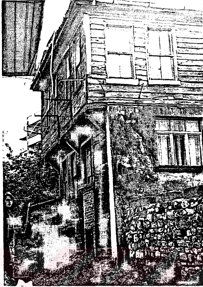
RESİM 45- CEPHESİ ÖNEMLİ ORANDA TADİ- LAT GÖRMÜŞ AHŞAP YAPI
