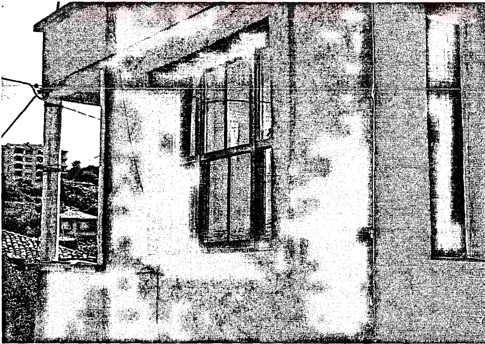
RESİM 74-ORJİNAL SÜRME PENCERE GÖRÜNÜŞÜ
