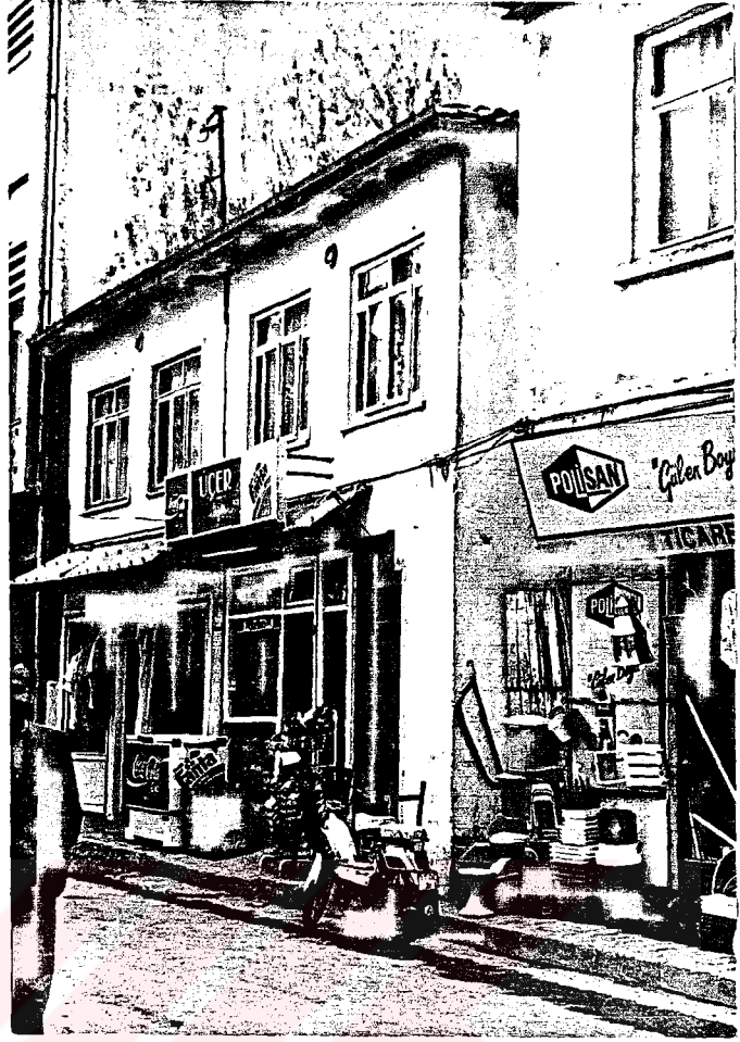
RESİM 27- AHŞAP YAPI SIVANARAK CEPHESİ BOZULMUŞ
