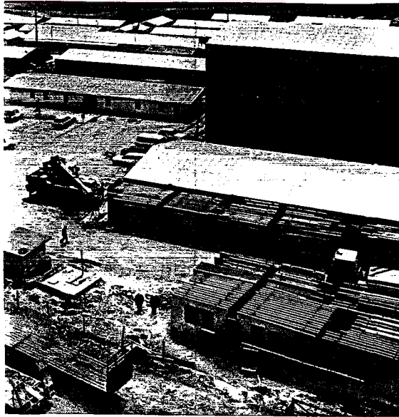
Şekil 2.21. Elemanların Açık Stoklama Parkında Depolanması (Mesa-Bahçeşehir).
