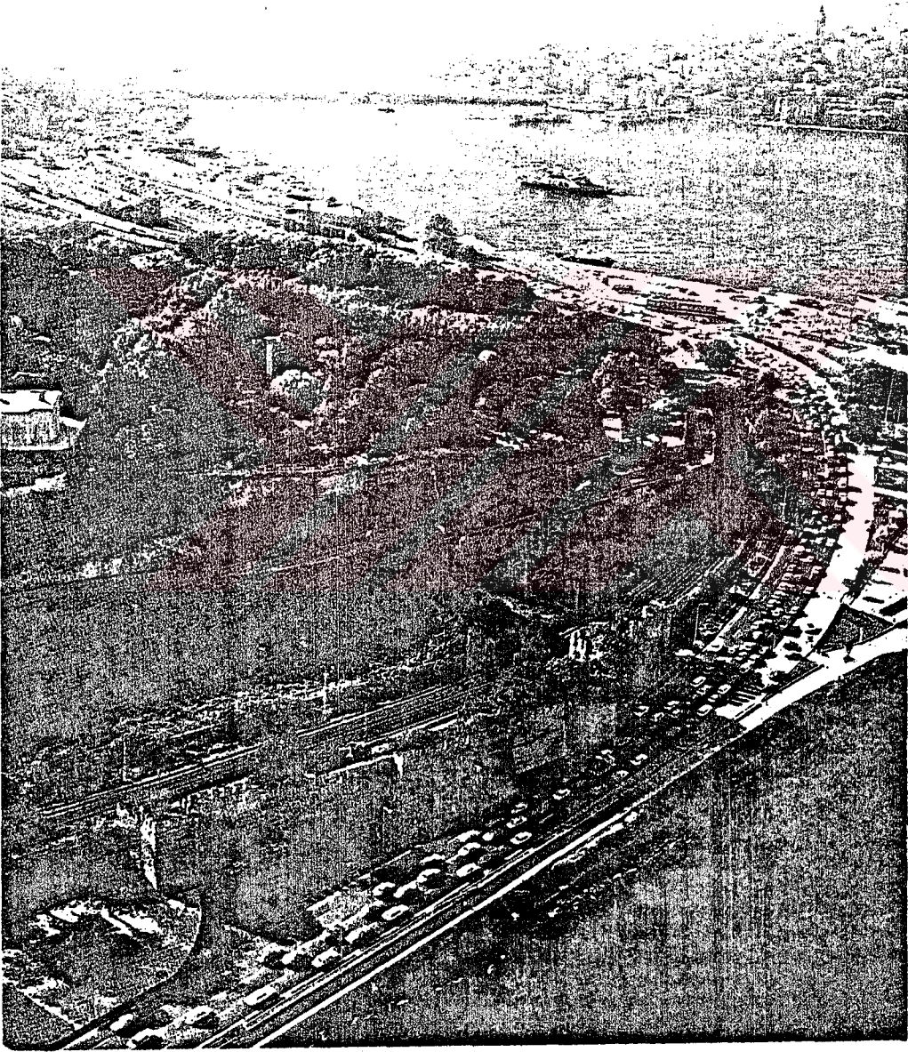
R.III.2.2. Sarayburnu Demiryolu ve Sahilyolu
