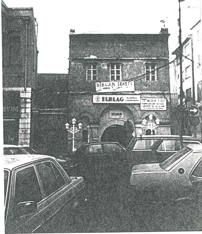
FETHİBEY CADDESİNDEN TAŞHAN'IN GİRİŞ CEPHESİNE BAKIŞ
