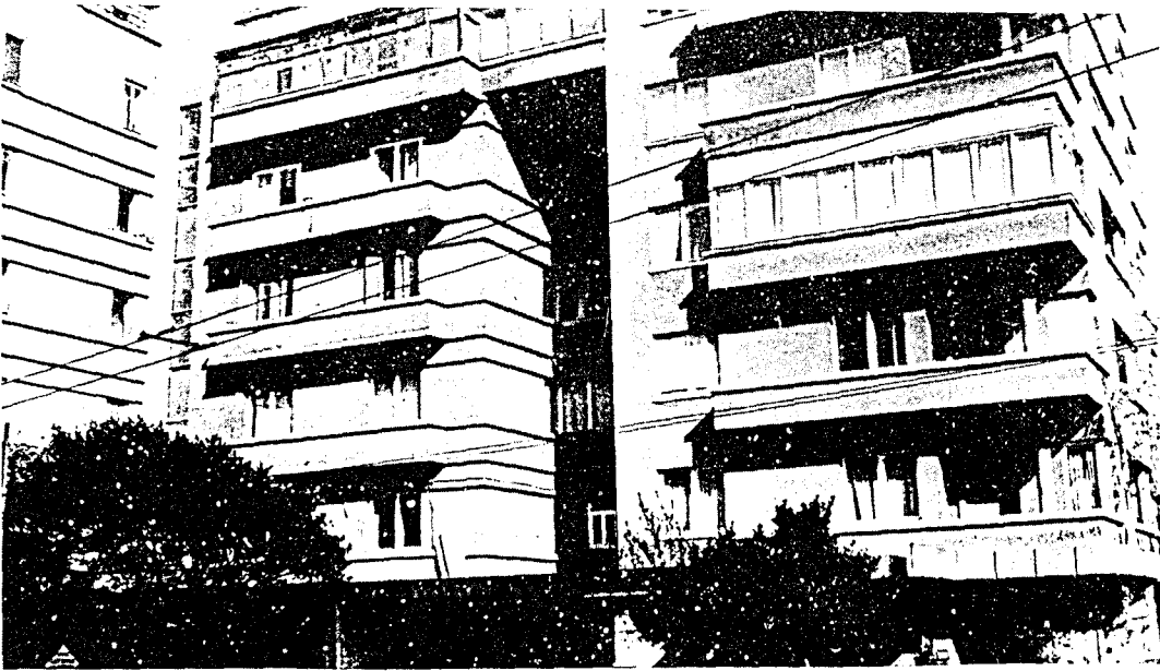
Üçler Apartmanı, Ayazpaşa, İstanbul, 1935, Seyfi Arkan
