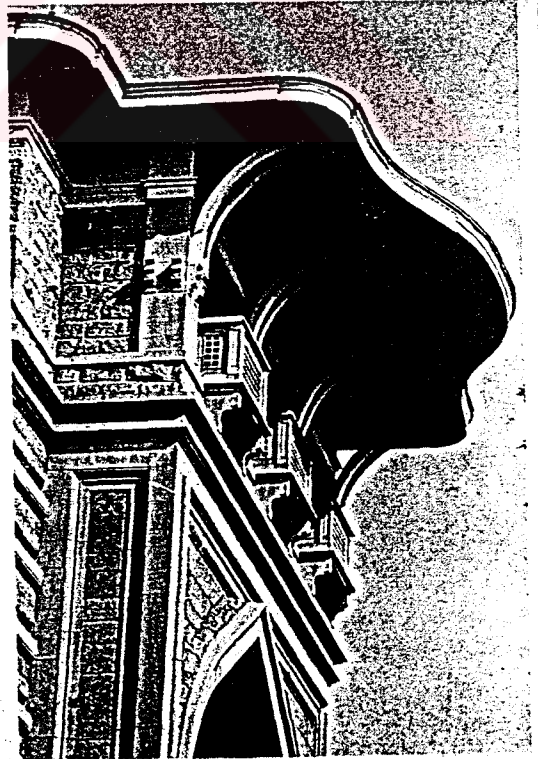
İstanbul Erkek Lisesi giriş saçağı
