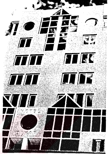
Diyar Otel yenileme projesi, Bursa, Mimarlık Araştırma- ları Stüdyosu
