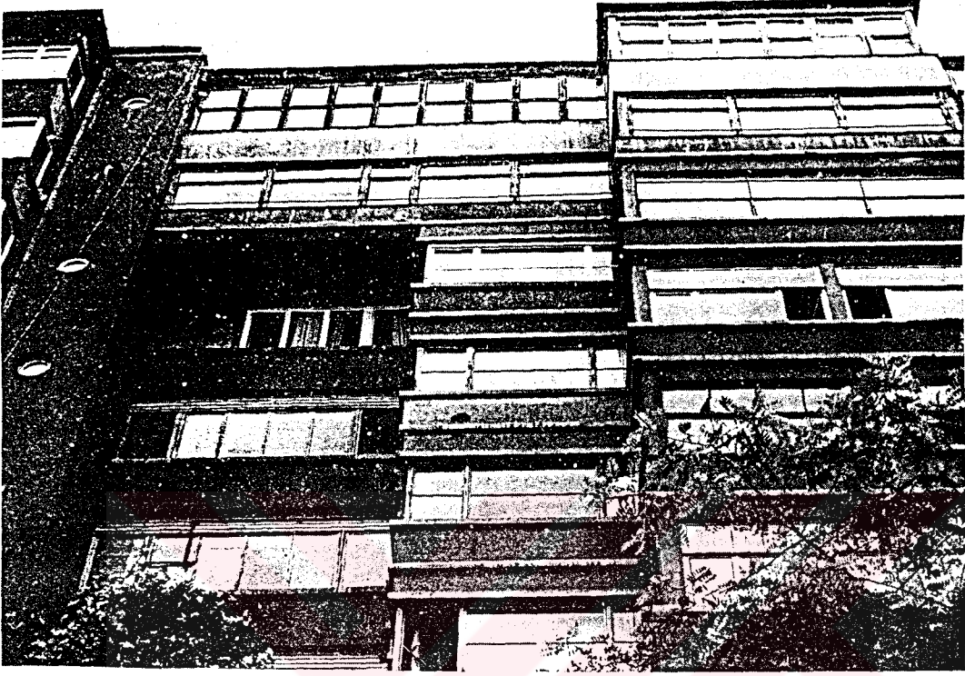
Üçler Apartmanı, Ayazpaşa, İstanbul, 1935, Seyfi Arkan
