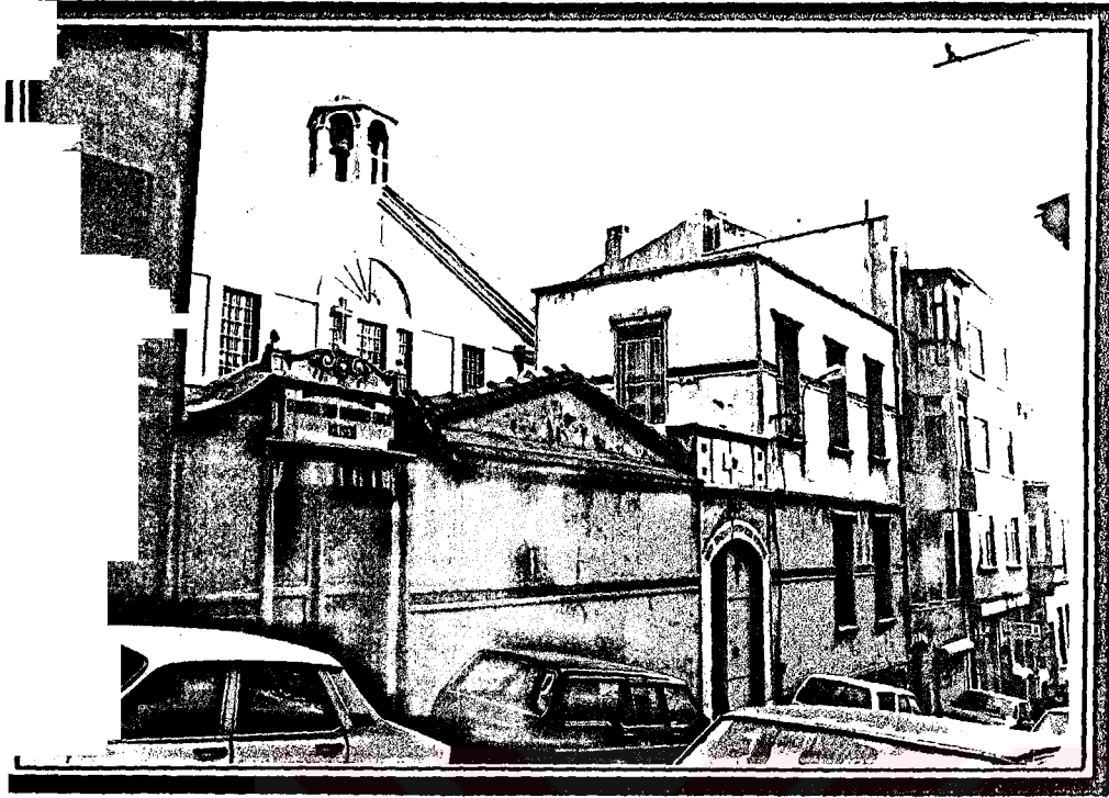
Resim: 15 Gedikpaşa Surp Ovhanes Kilisesi
