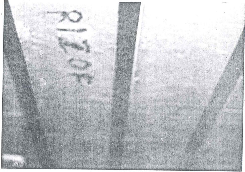
Resim 200- Aziz Stefan Bulgar Kilisesi bodrum tavan döşemesi ve ara kirişler
