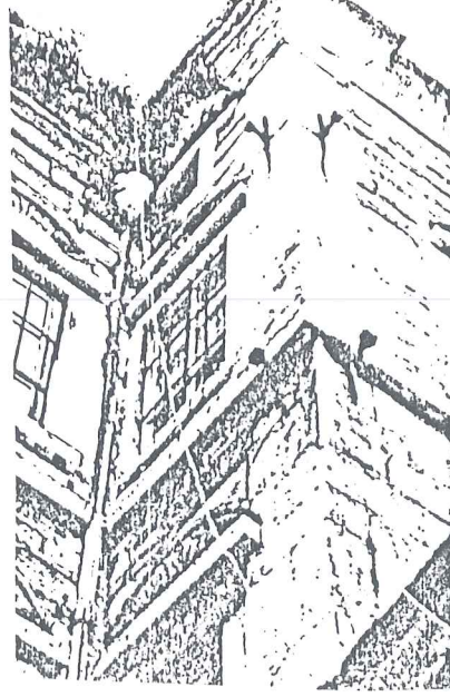
(Resim: 136) Büyük Yıldızhan cephesinde yapının duvarlarını kuşatan kuşaklamalarının kılıçlı bağlantıları.
