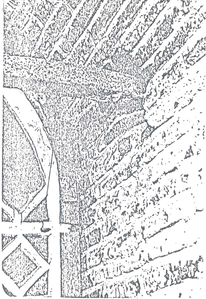
Resim: 140 Üç şerefeli camiisinde kubbe etek pencereleri içinden geçen demir kuşaklama çemberi. (Tanyeli'den)
