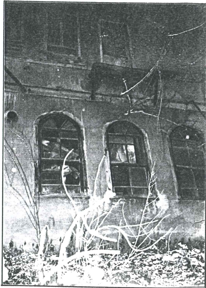
Resim 107. Kydeki tek yuvarlak kemerli pencere rneęi (Env. no:3).
