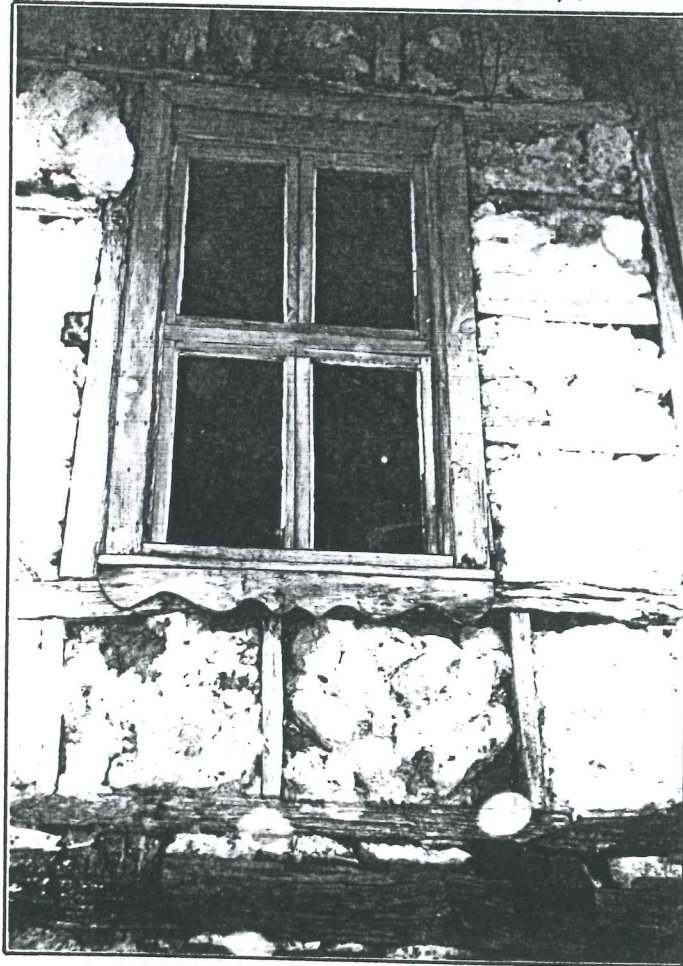
Resim 105. Süslemeli alt pervaz örneđi.
