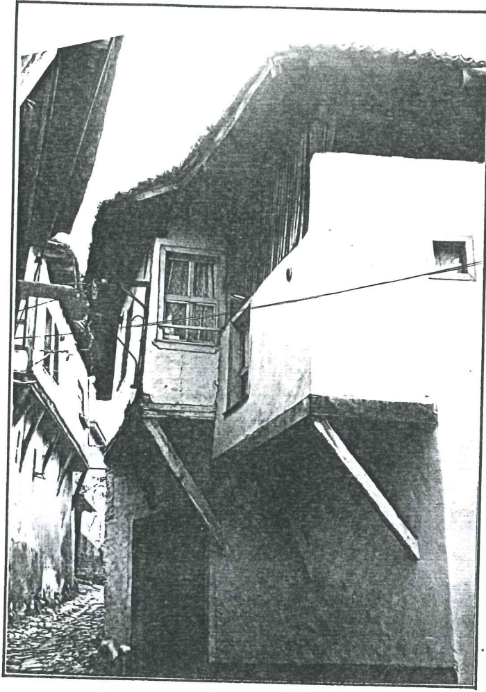
Resim 92,93. Payandalar ve eli böğründeler tarafından taşınan gönyeli çıkma tipine iki örnek. (Env. no:57,20).
