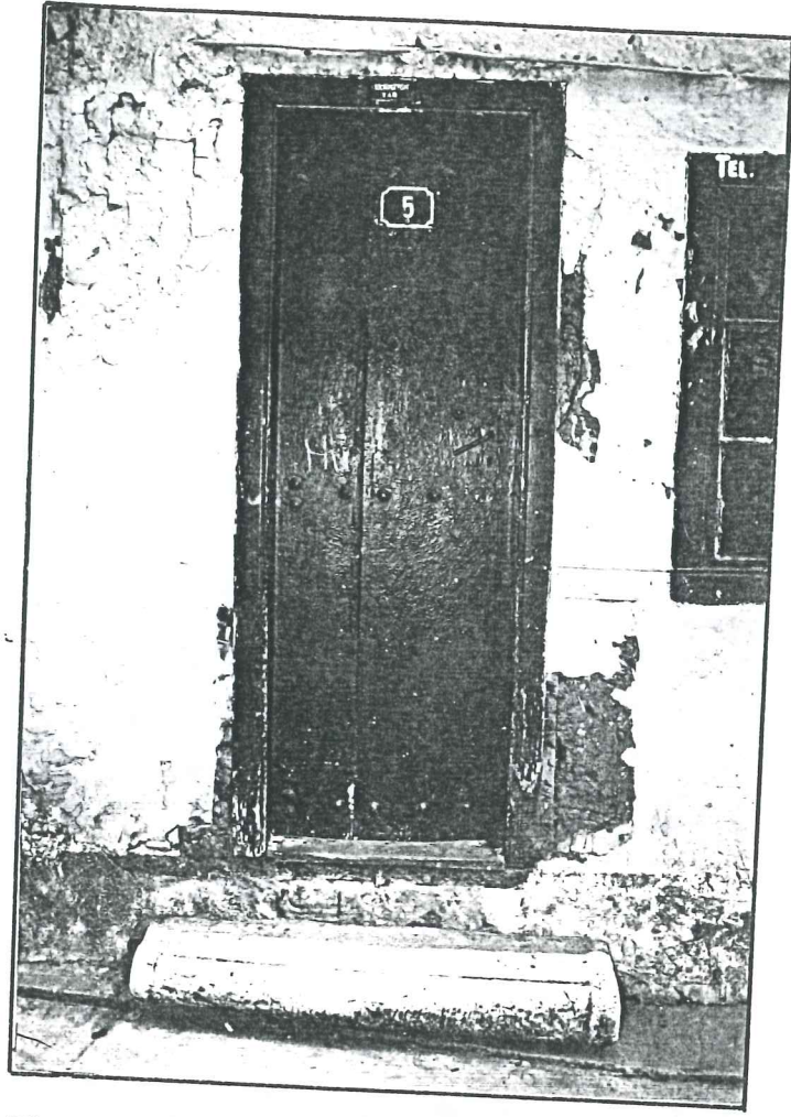
Resim 26: Elektrikçi dükkanının kapısının önündeki basamak olarak kullanılmış sütun parçası (Env. no. 33)
