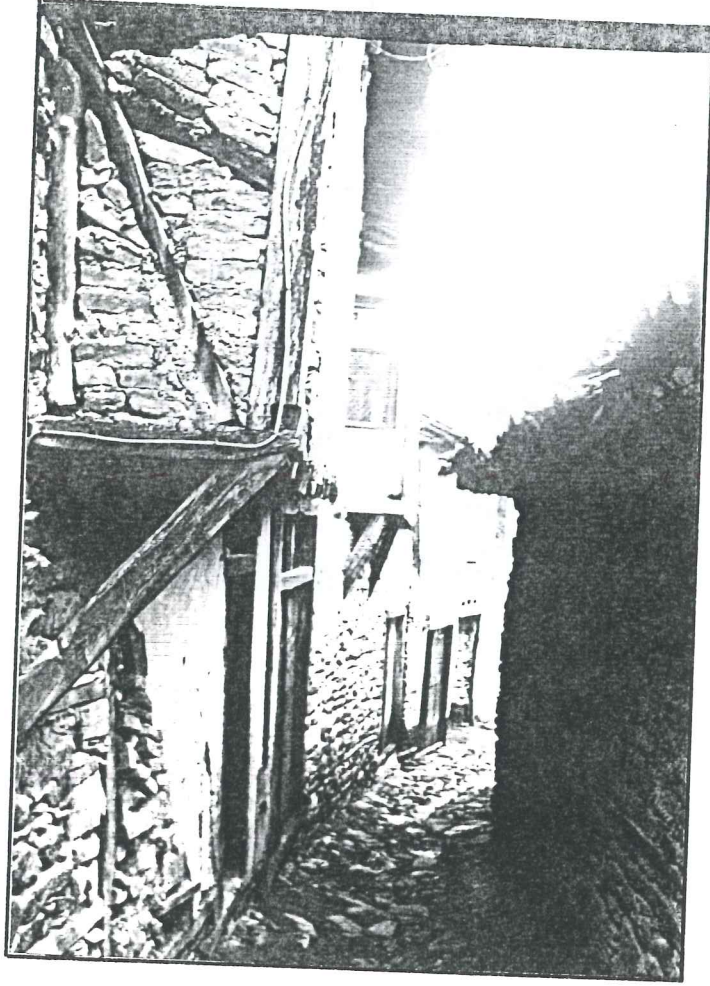
Resim. 42. Üçlü Sokaktan görünüm.
