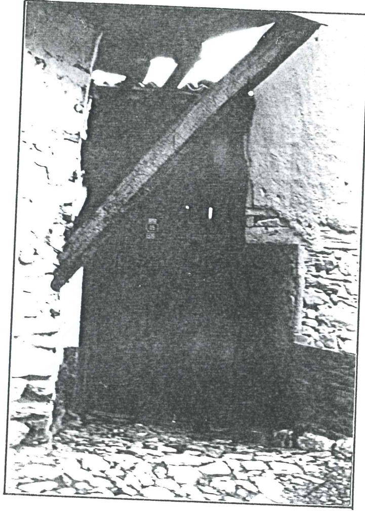
Resim 141. Üzeri saçaklı bir bahçe kapısı örneği
