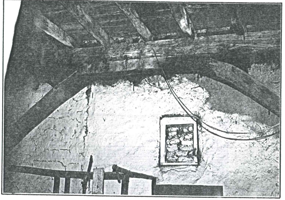
Resim 117. Hayat'a açılan üzeri badana ile boyanmış bir tepe penceresi örneği
