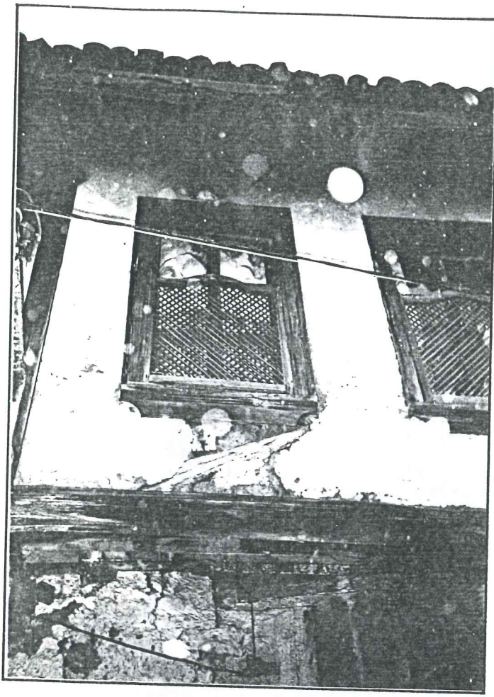
Resim 129. Düz ahşap kafesli pencere
