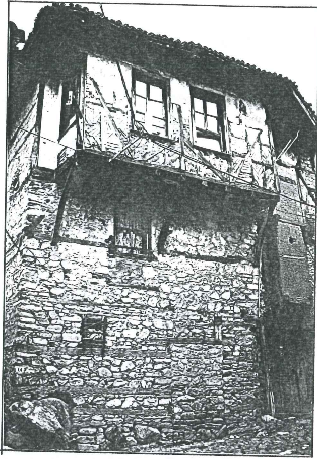
Resim 90. Eli bögürndeler tarafından taşınan tek çıkma örneği (Env. no:145).
