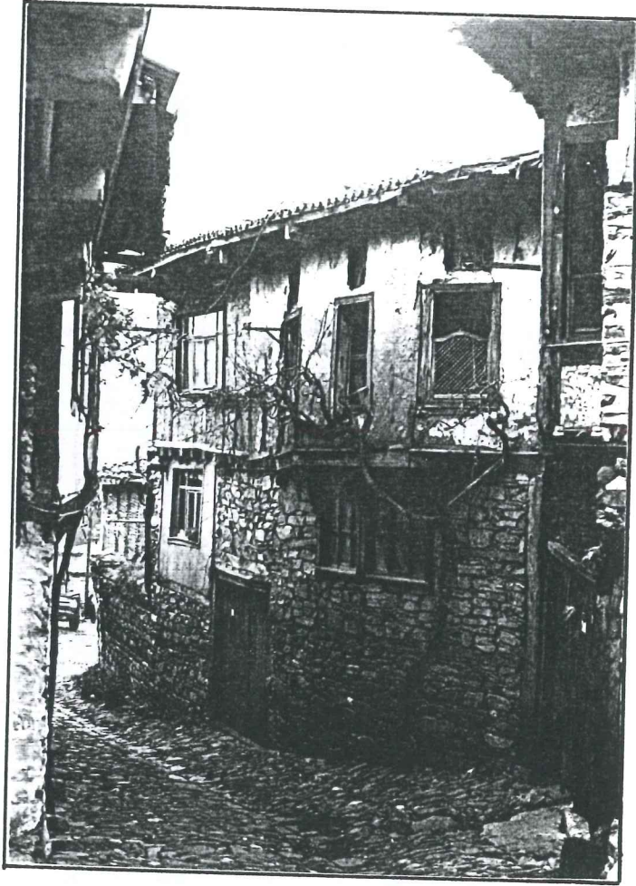
Resim 79. Zemin kat ile üst kat arasına yerleştirilen "Kışlık Kat".
