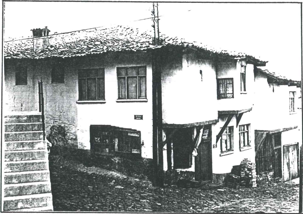
Resim 92,93. Payandalar ve eli böğründeler tarafından taşınan gönyeli çıkma tipine iki örnek. (Env. no:57,20).
