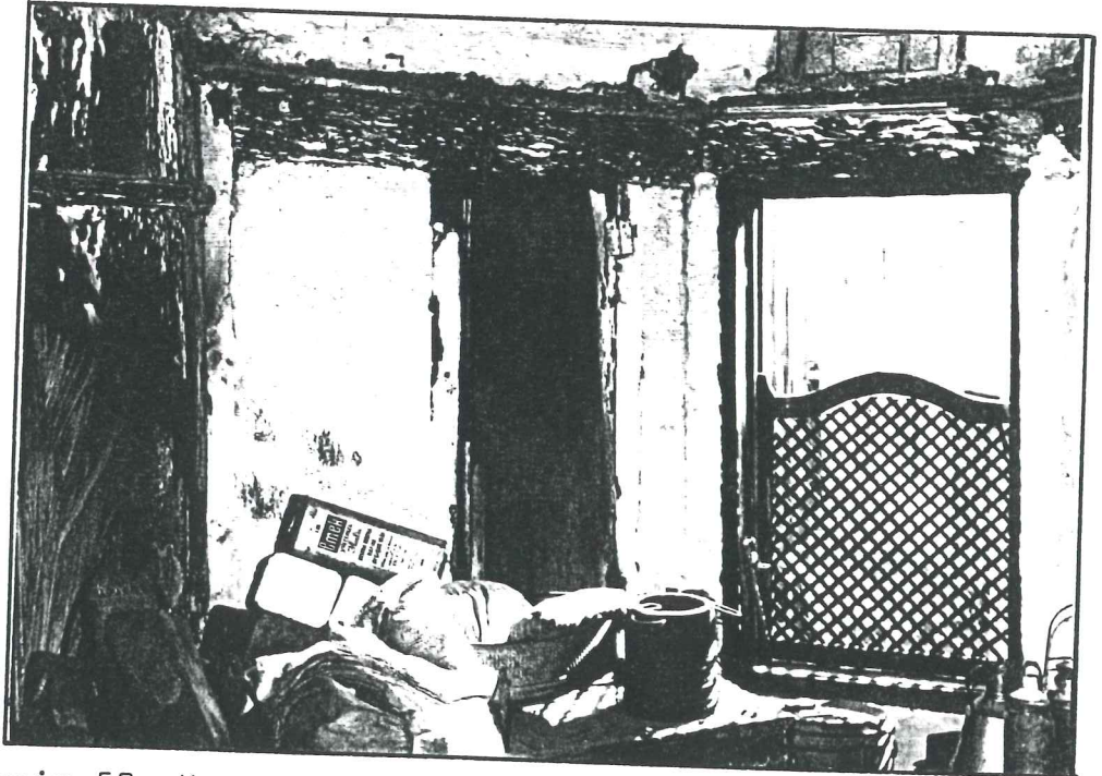
Resim 59. Kapı, pencere ve dolapların üst sınırını belirleyen "raf silmesi".
