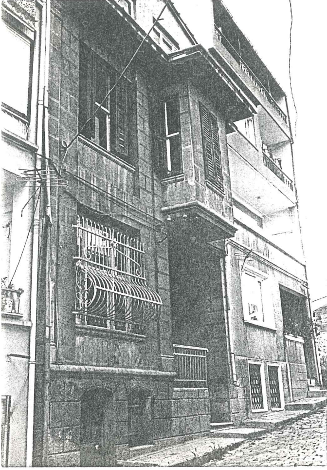
RESİM 29- Toraman Sokak'ta 124 no.lu adada bulunan kagir ev (iki simetri ek- senli cephe örne- ği)
