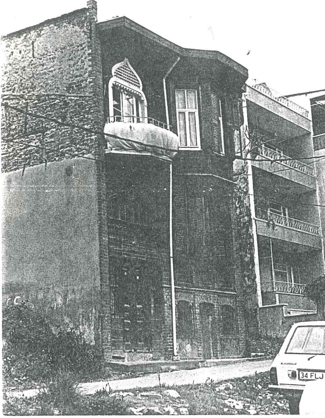
RESİM 23- Kestane Sokak, 132 no.lu adada bulunan 6 no.lu ahşap ev. (Kenar- ları pahlı çıkma örneği)
