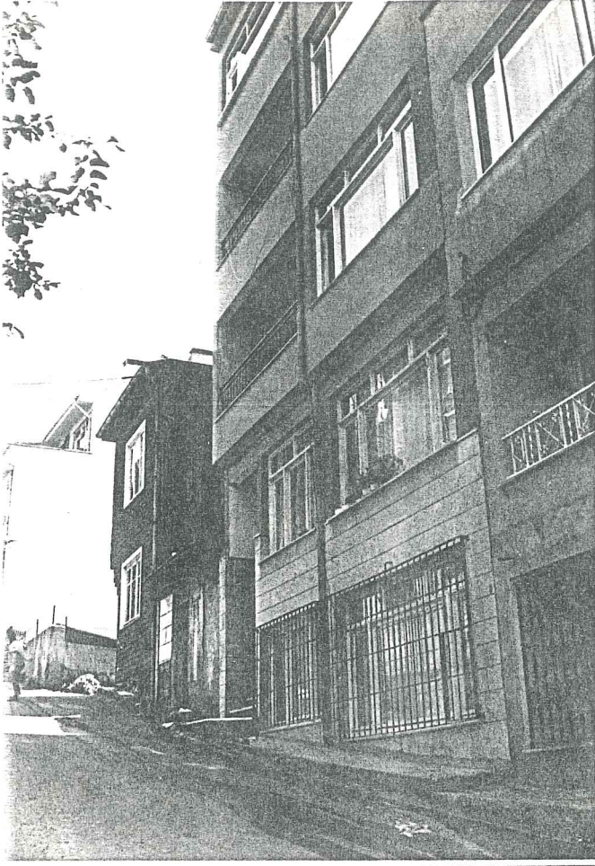
RESİM 62- Dönüm Sokak'tan görünüm (Yeni yapılaşma örneği)
