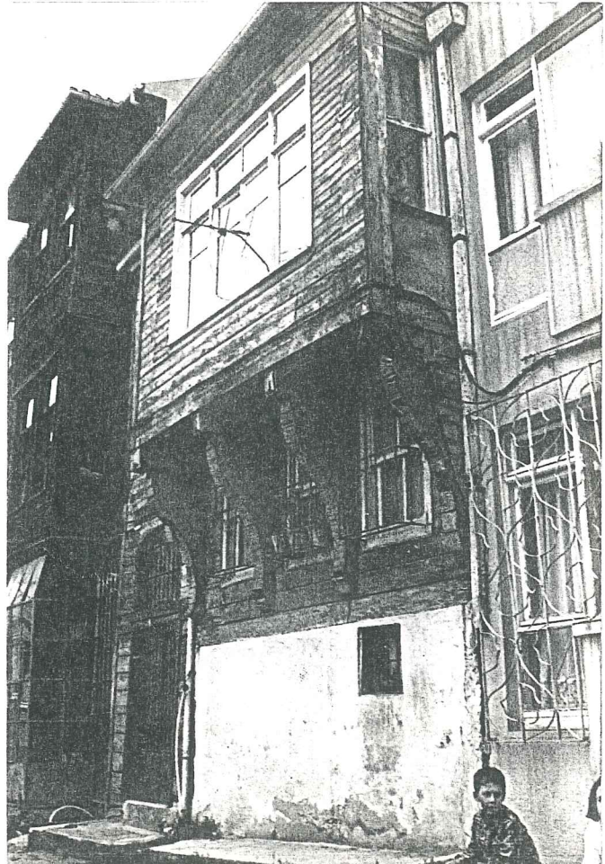
RESİM 38- Dönüm Sokak'ta 19 no.lu ahşap ev (4'lü ahşap konsol giriş örneği) (Bkz. plan ve görünüşler)
