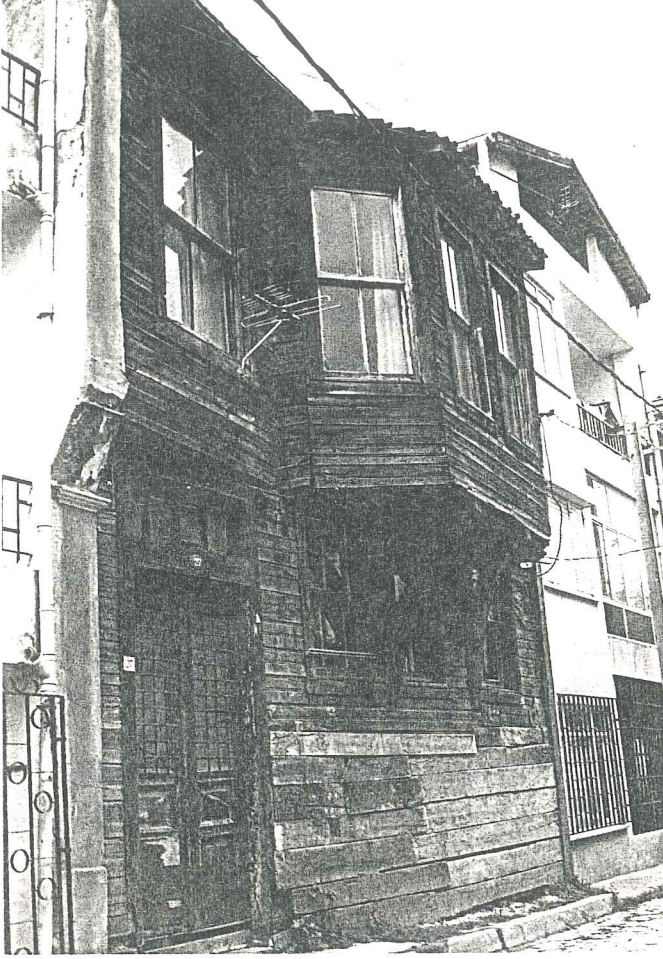
RESİM 43- Toraman Sokak'ta, 125 no.lu adada, 27 no.lu ahşap ev (Eğrisel payanda örneği)
