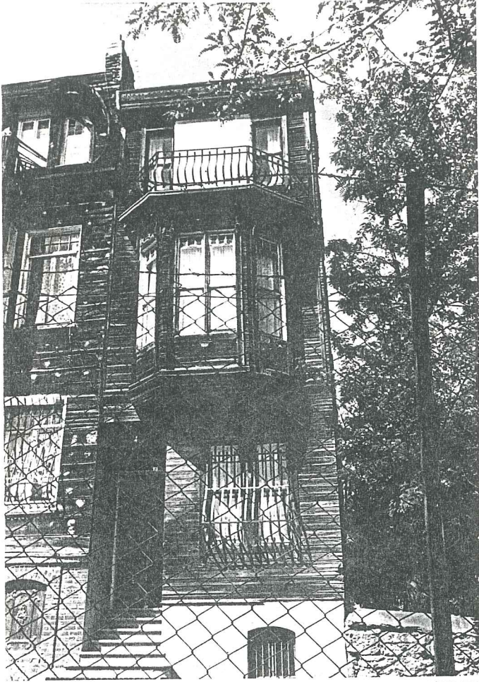
RESİM 41- Şirin Sokak'ta 2 no.lu ahşap ev (Çıkma altı eğri-sel olarak kapatılmış)
