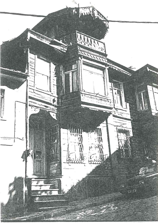
RESİM 27- Çam Fıstığı So- kak'ta 117 no.lu adada 7 no.lu ah- şap ev (iki si- metri eksenli cephe örneği)
