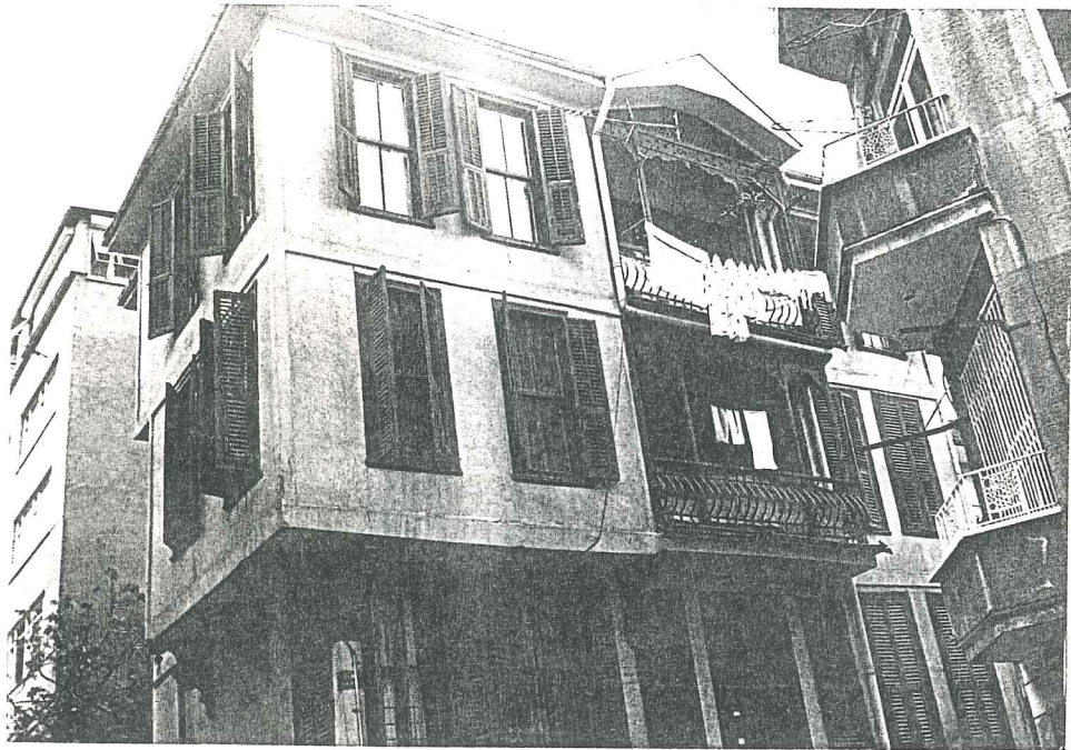
RESİM 40- Dönüm sokak ile Hekim Ata Caddesi'nin kesiştiği köşe parselde bulunan 1 no.lu cephesi sıvanmış ahşap ev (3'lü ahşap konsol kiriş örneği. Bkz. Plan ve görünüşler)
