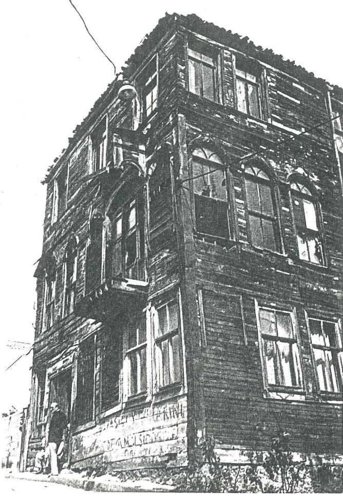
RESİM 53- Seksek Sokak ile Boyacıköy Çeşme Sokak'ın kesiştiği köşe parselde bulunan ahşap ev (Kemerli ve Düz, Tek Pencere tipi örneği) Kapı No:5
