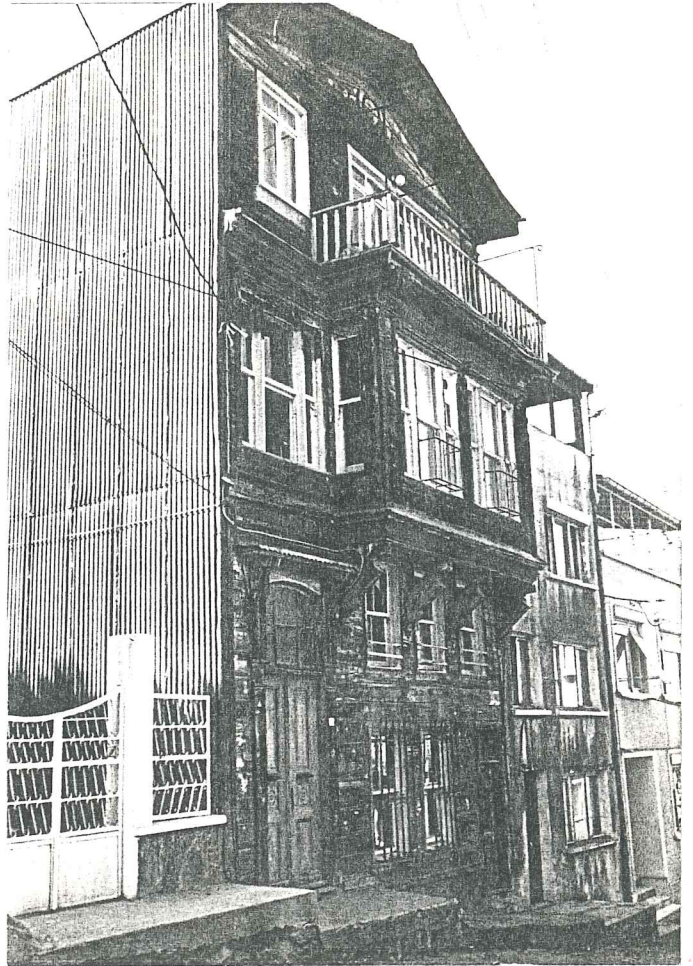
RESİM 28- Boyacıköy Yokuşu sonunda 110 no.lu adada 8 no.lu ah- şap ev (iki simet- ri eksenli cephe örneği)
