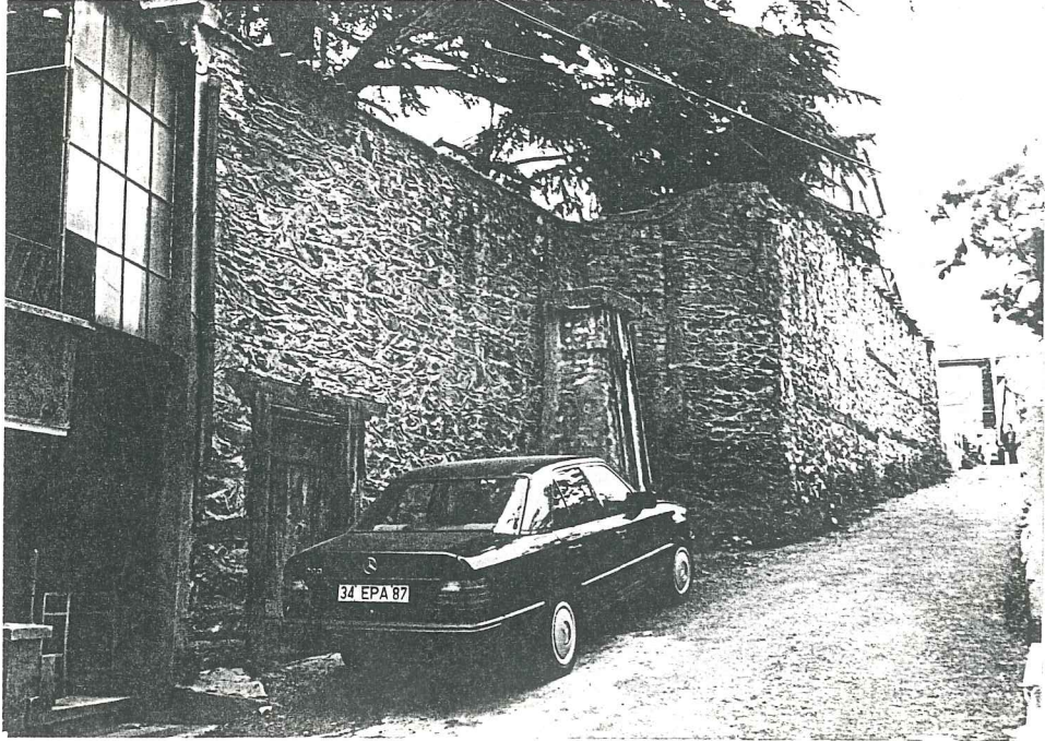
RESİM 89- Bahçe duvarı ve kapısı ile su terazisi görünümü (Setüstü Sokak 69 no.lu parsel)
