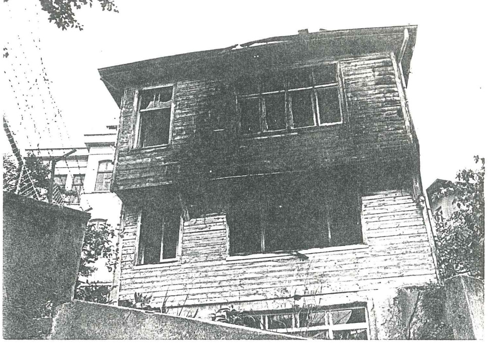
RESİM 54- Tek katlı - cephe boyunca - dikdörtgen çıkma örneği (Pazar Yanı Sokak, no:9)
