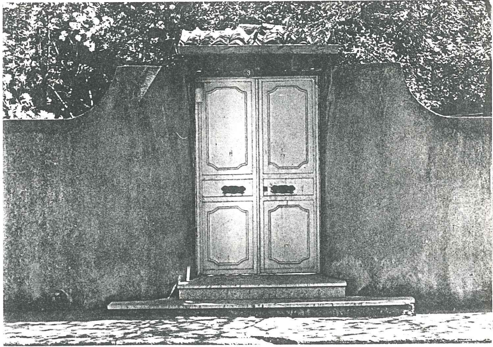
RESİM 87- Bahçe kapısı örneği (Riyaziyeci Sokak No:3)
