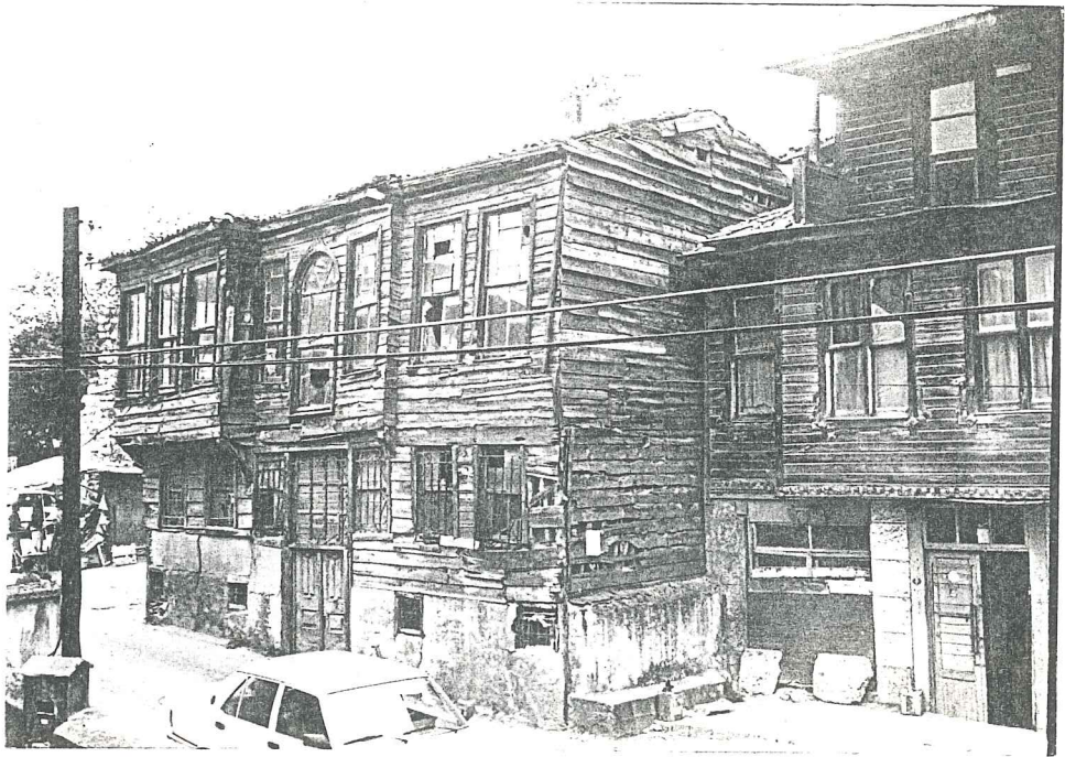
RESİM 81- (Kızılsırçe Sokağı 1 no.lu yapı) Yalı baskısı, ahşap kaplama örneği
