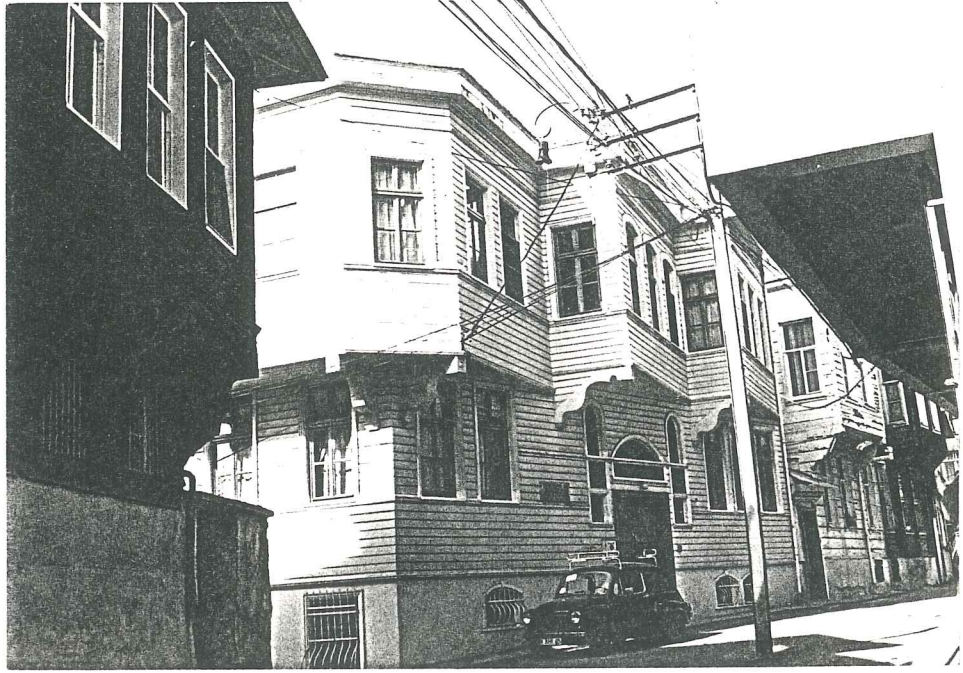
RESİM 95- II. grup restorasyon uygulaması örneği (Setüstü Sokak No:13)
