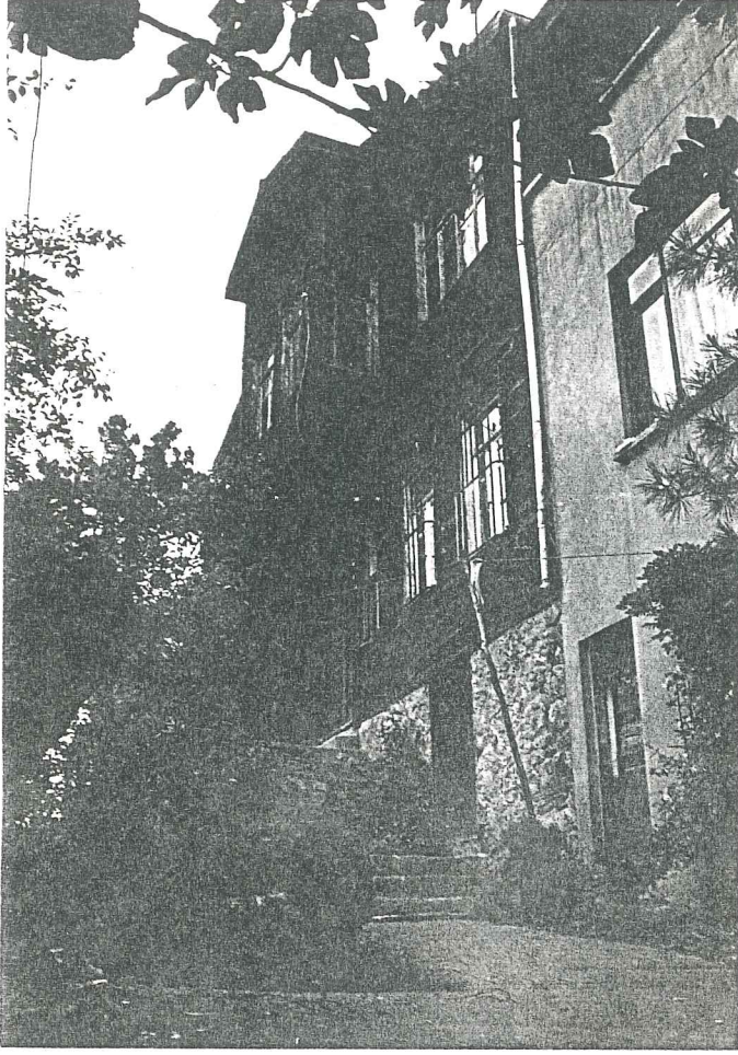
RESİM 46- Tek katlı -ortada- dikdörtgen çıkma örneği (Pazar çıkma Sokağı, No.9)
