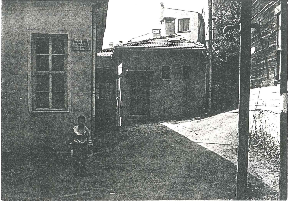
RESİM 96-Kagir yapının restorasyonu (Setüstü Sokak No:24) (Bkz.Plan ve silüet)
