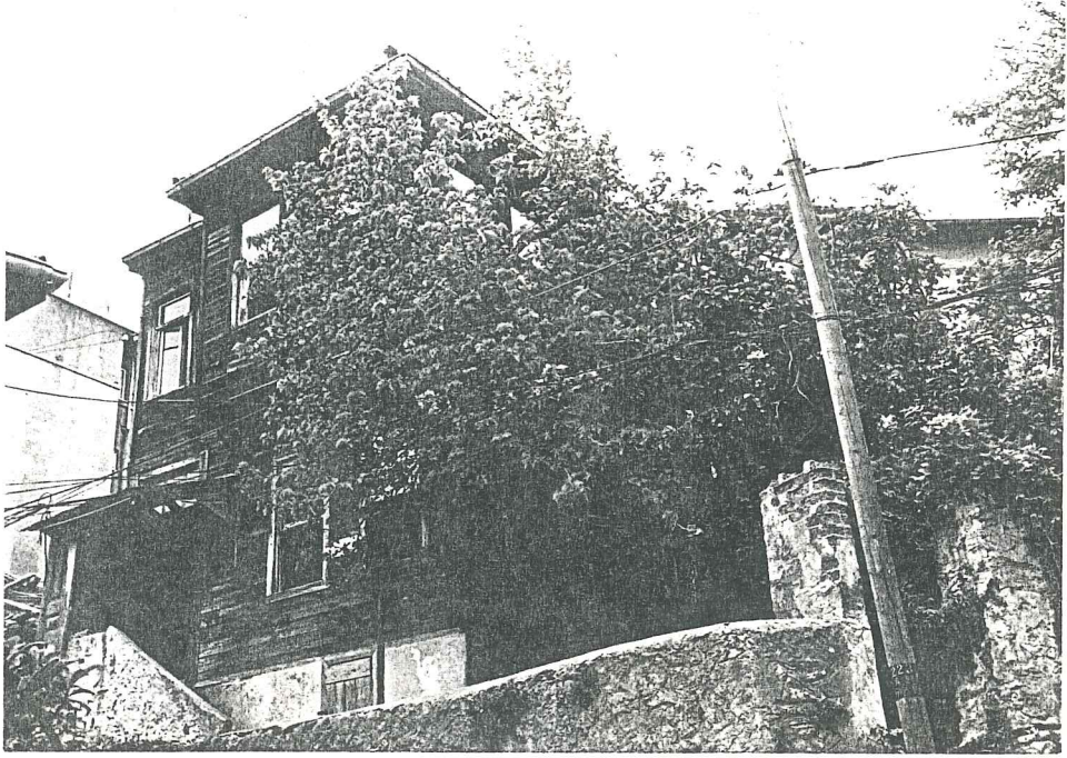
RESİM 49-Tek katlı - yanda - dikdörtgen çıkma örneği (Sinan Paşa Sokak, no:2)
