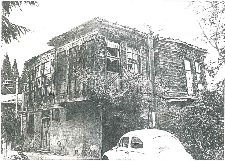
RESİM 56-Tek katlı - iki yönlü - dikdörtgen çıkma örneği (Setüstü Sokak no:1)
