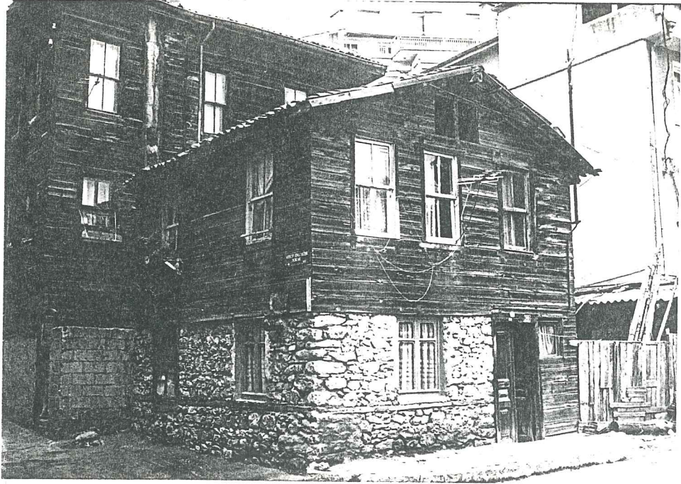
RESİM 75-Yandan girişli-cepheyle aynı yüzde-2 kanatlı, 3 tablalı ahşap kapı (Kızılserçe Sokağı, No:29)
