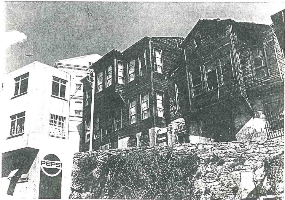
RESİM 71- Konsol kirişli çıkma örnekleri (Setüstü Sokak No:2 ve 4)
