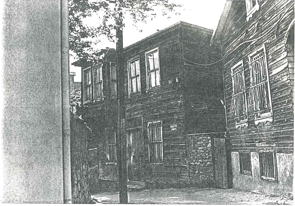
RESİM 62- İki simetri eksenli cephe örneği (Otağtepe Caddesi no:1) (Bkz. plan ve silüet)
