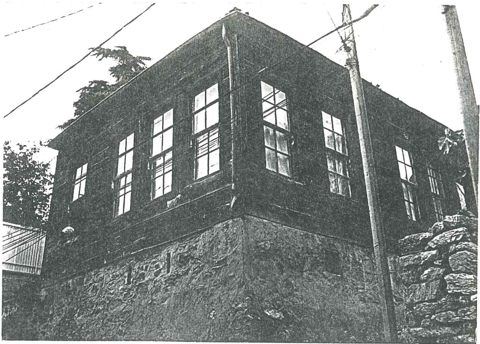
RESİM 77-Tek düz pencere tipi örneği (Hisar Cami Sokak) (Bkz. Plan ve Silüet)
