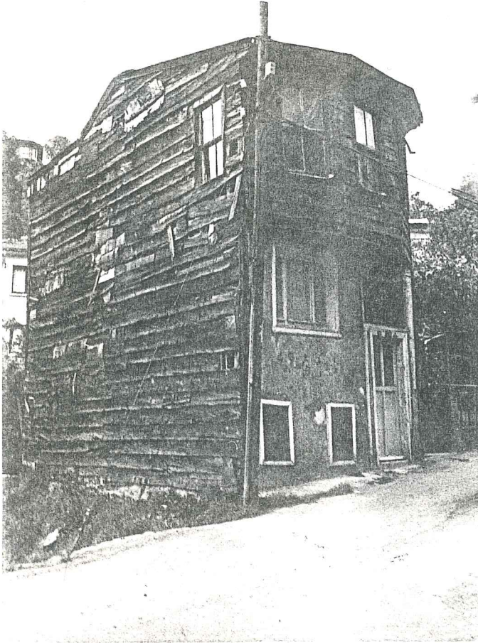
RESİM 55- Tek katlı - cephe boyunca - pahlı çıkma örneği (Pazar Sokak no: 21)
