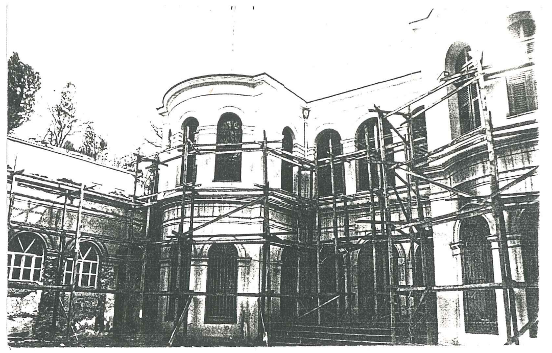
Küçük Mecidiye Cami, giriş cephesi
