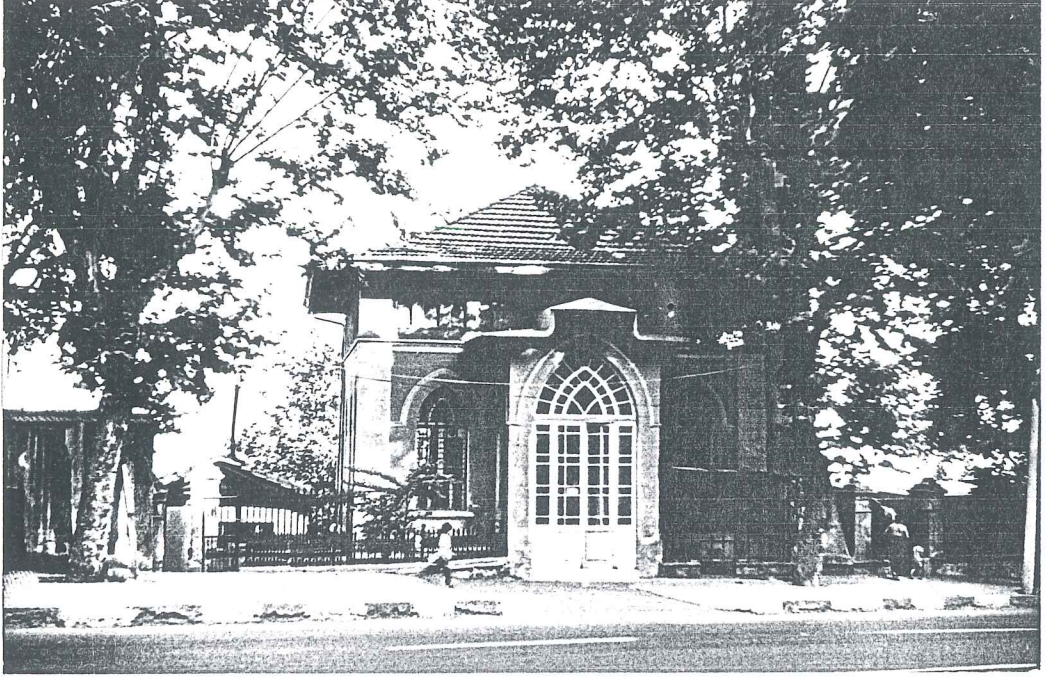
Osman Reis Cami, giriş cephesi
