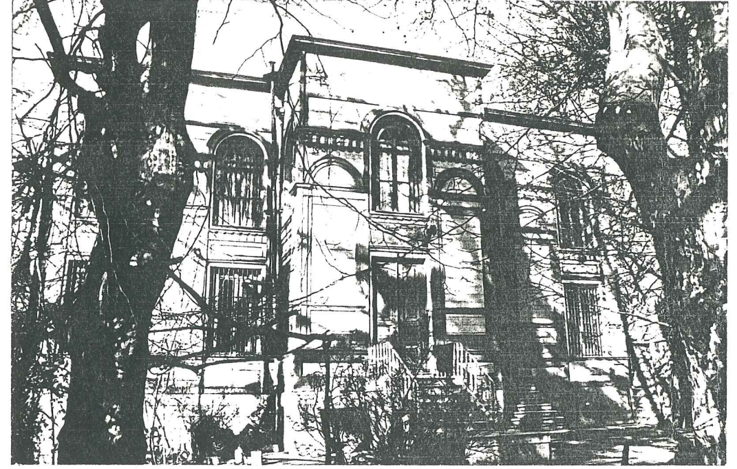
Ertuğrul Cami, güney cephesi
