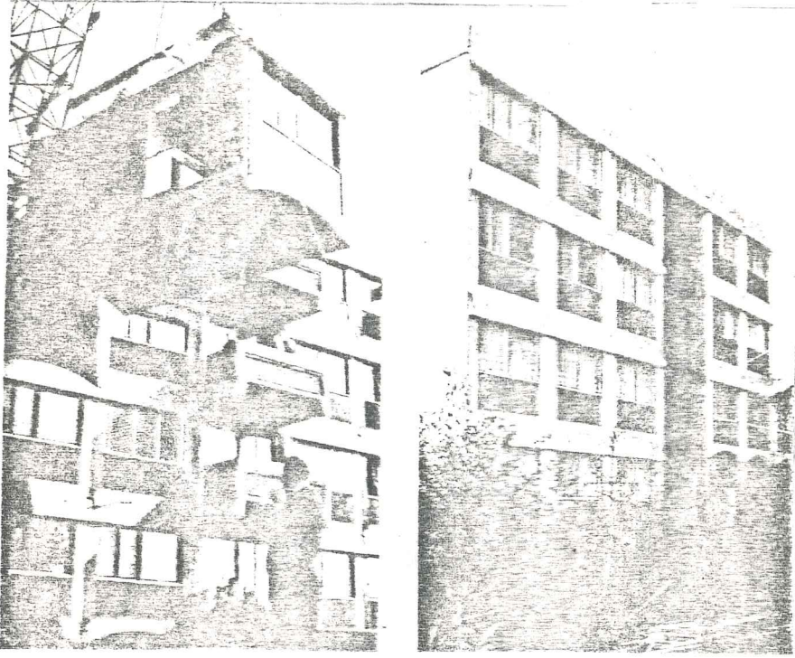
Yığıma blok sistemi ile kapalı hücrelerle inşa edilen bina Flexbau sistemi İsviçre
