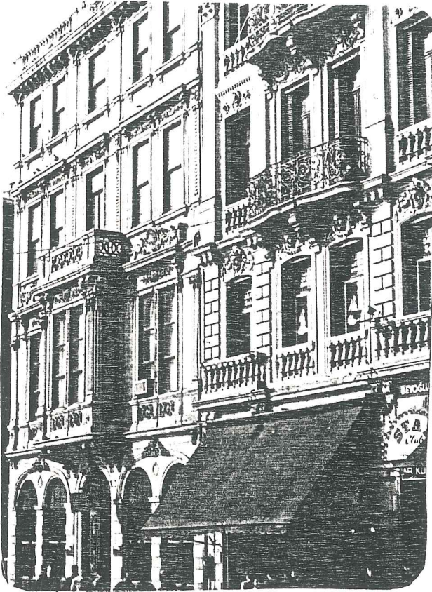
Resim 55- Çiçek Pasajı, diğer adıyla Hristaki Pasajı'nın onarım çalışmaları.
