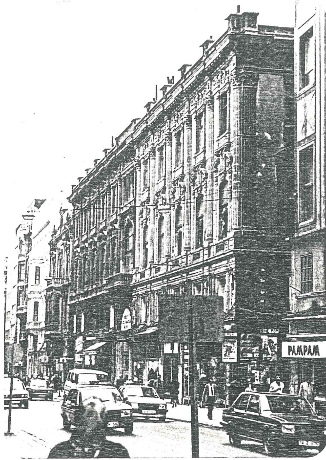
Resim 91- İstiklâl Caddesi'nde 120-132 kapı no'lu yapı. Yüze- yinin yarısı temizlenmiş. Yan yüzeyde ise ka- buklanmalar görülüyor.
