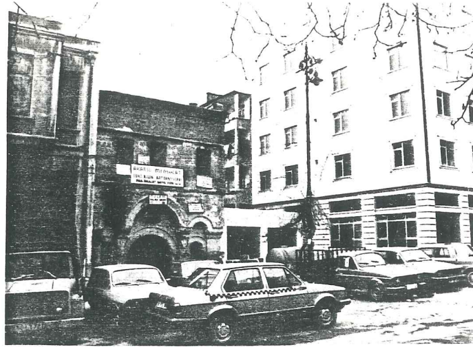
F. 56. Taşhan giriş kapısı.
