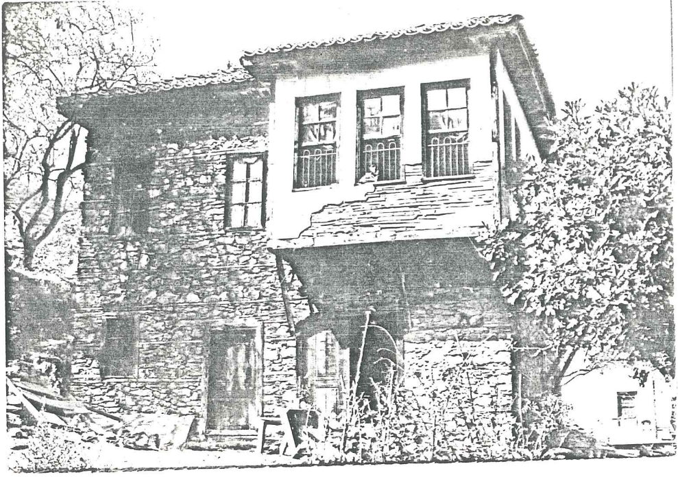
(Fotoğraf 94) 5 x 10 ahşapla çıkmanın taşınması
