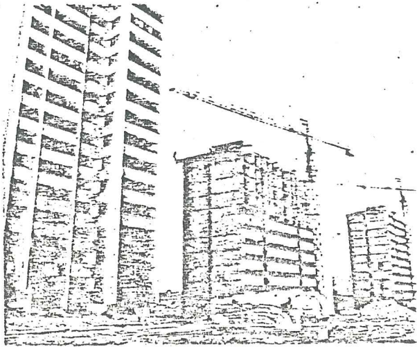
Şekil 25 . Mesa şantiyesinden görünüm.
