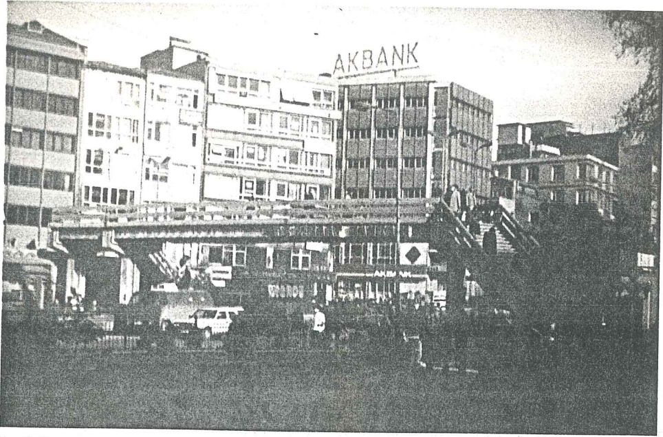
Kadıköy'de Yaya Sorununa Çözüm İçin Yapılmış Üstgeçit'ten Görünüş
