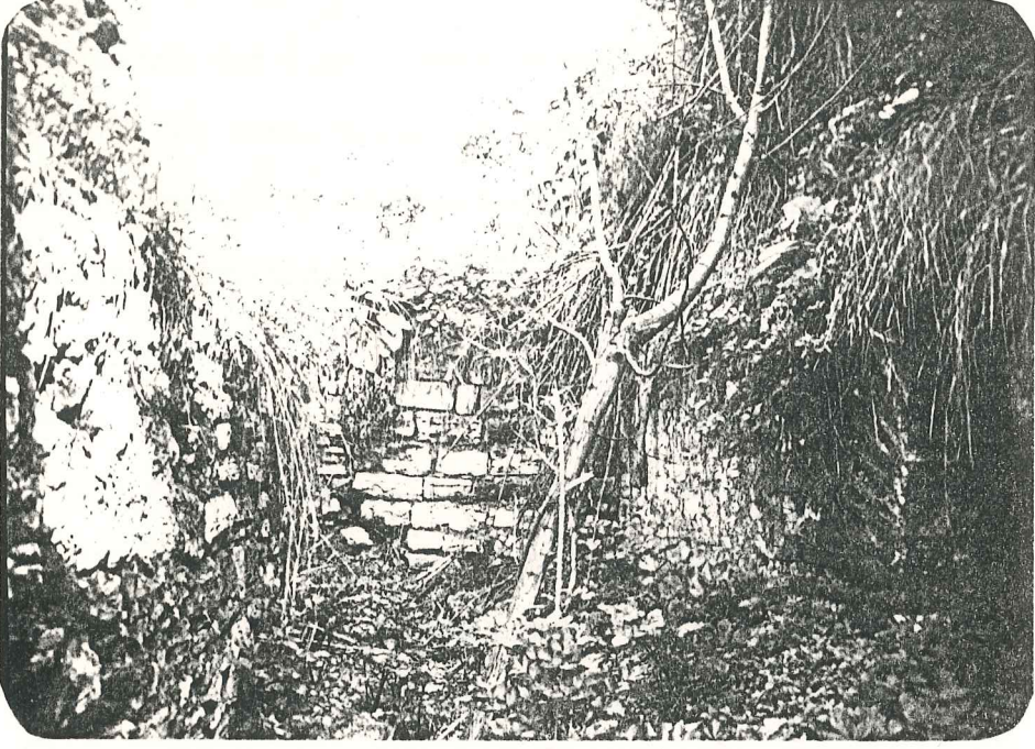
Resim 33- 10 numaralı odanın görünüşü. Tam karşıda 10b duvarı bulunmaktadır.
