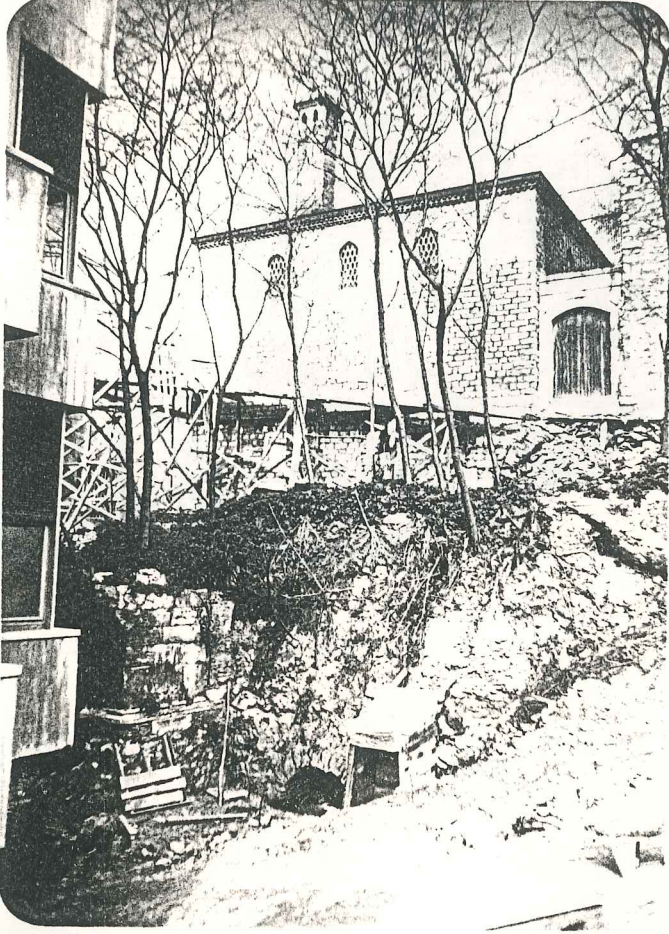
Resim 40- Sarnıca su sađlayan su kanalının uzantısı grlmektedir. Bu kanal Topkapı Sarayının altından geerek denize ulařmaktadır.
