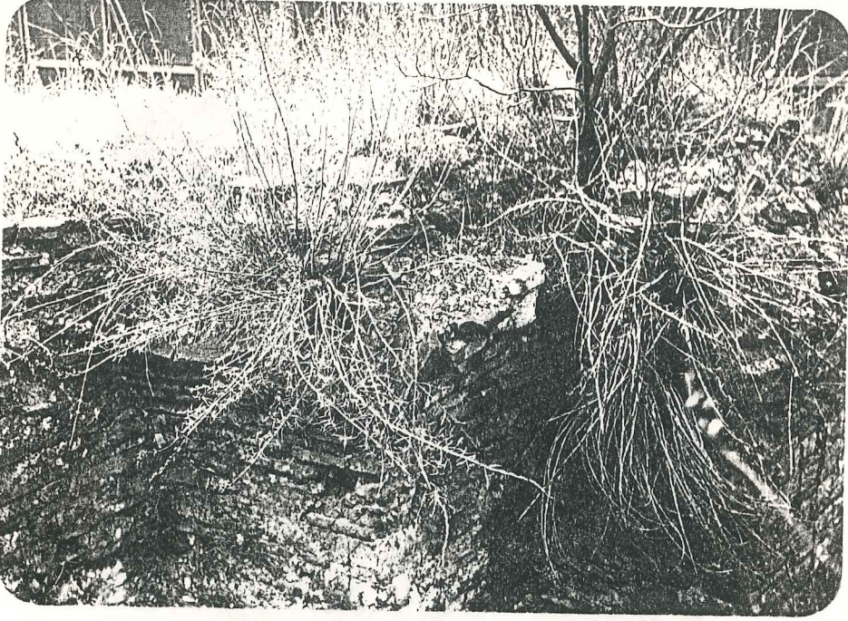
Resim 19- 5 numaralı odanın 5a duvarından görünüş.
