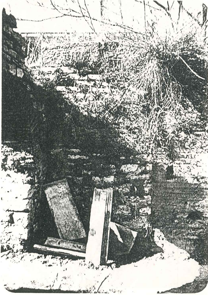
Resim 10- 2 numaralı portiğın 2b duvarından görünüş. Tuğla duvara bitişik 5 sıra taş + 5 sıra tuğla duvar görülmektedir.
