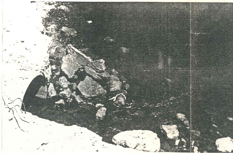
DENİZE AÇIK OLARAK VERİLEN KANALİZASYON
