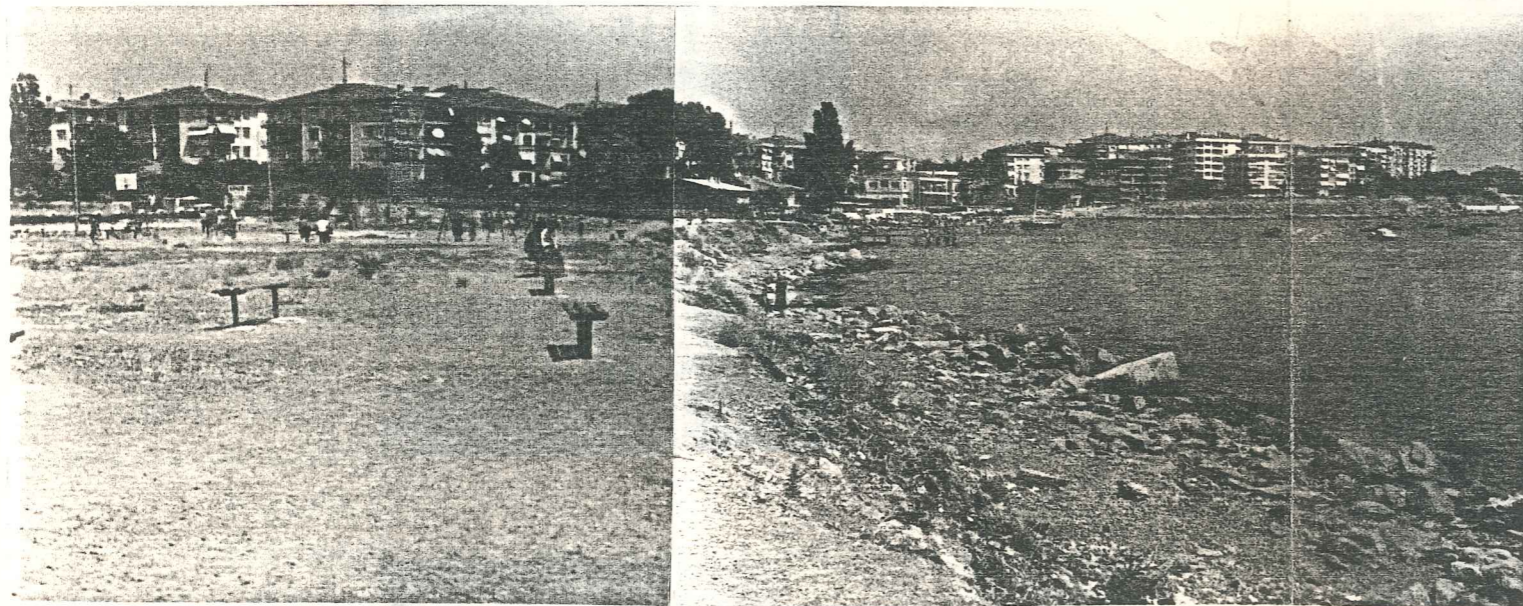
PARKIN KIYIDAN GÖRÜNÜŞÜ
