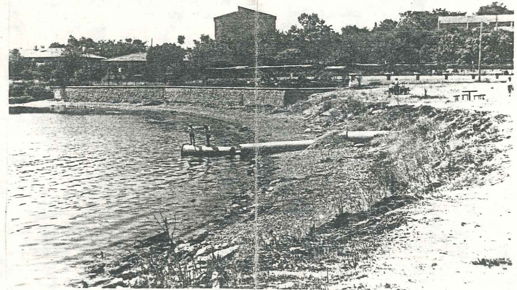
DOLGUNUN ALTINDAN DENİZE AÇIK OLARAK VERİLEN KANALİZASYON
