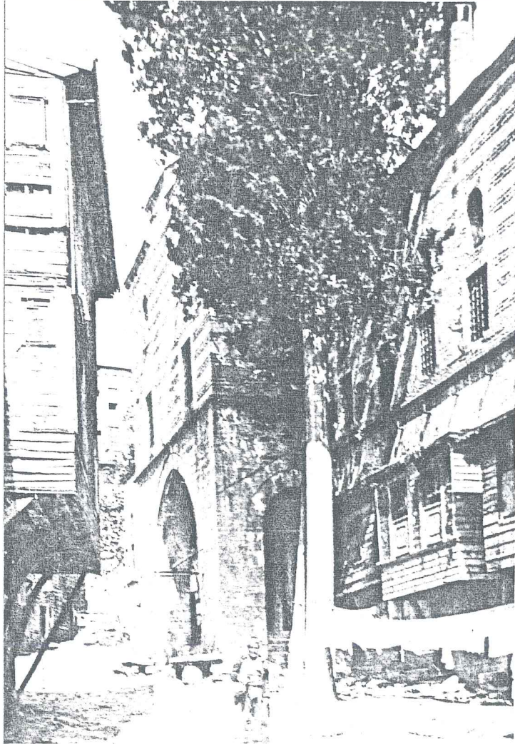
R.71- Giriş Cephesi, (Gurlitt).
