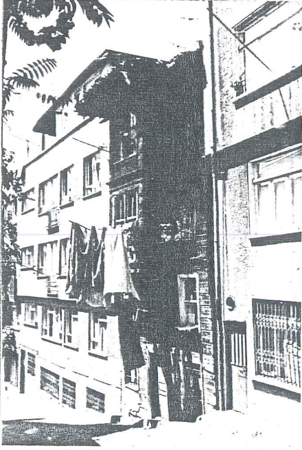
R.141- Şehit Mehmet Paşa Yokuşunda Bir Yapı (Yangından önce).
