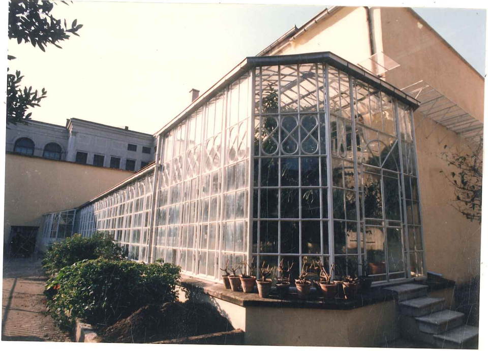
Resim 14- Hareket Köşklerinin Bulunduğu Bahçede Yeralan Eski Sera
