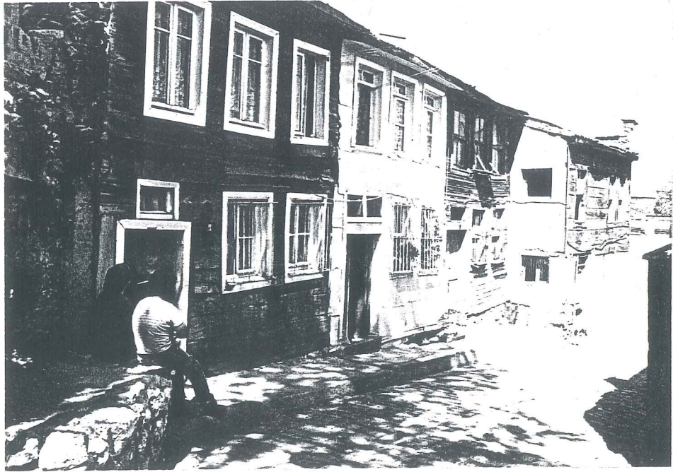
Resim 61- Marul Sokak'ta özgünlüğünü yitirmiş ahşap sıra evler
