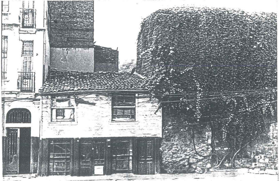
Resim 63- Sur duvarları arasında bir yapı
