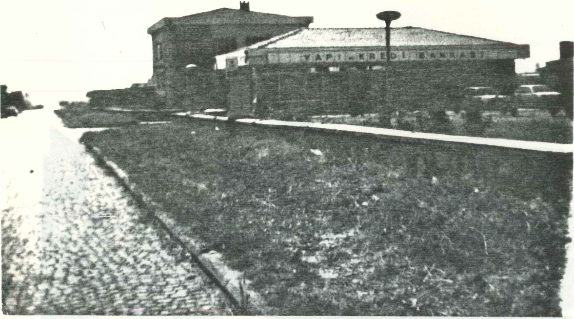
Organize Sanayi Bölgesi, PTT Binası ve Banka.
