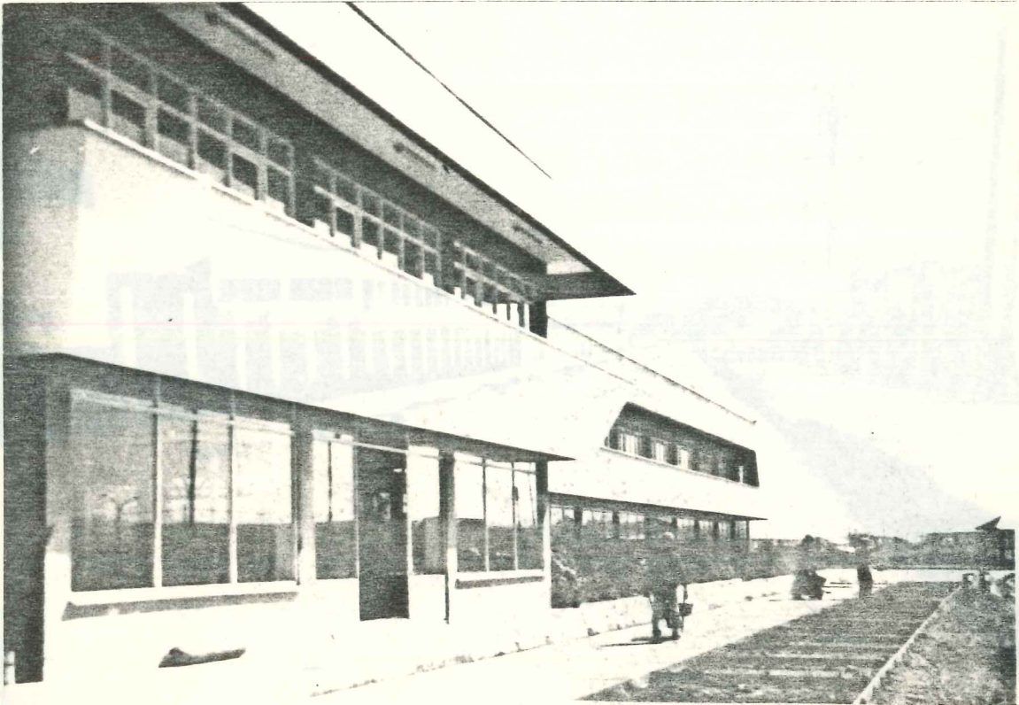
Organize Sanayi Bölgesinde Yapılmakta Olan Bir Fabrika Binası
