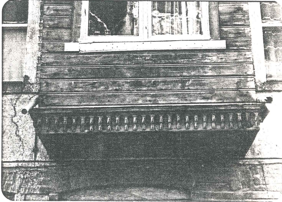
Resim 74- Ahşap kat silmesi
