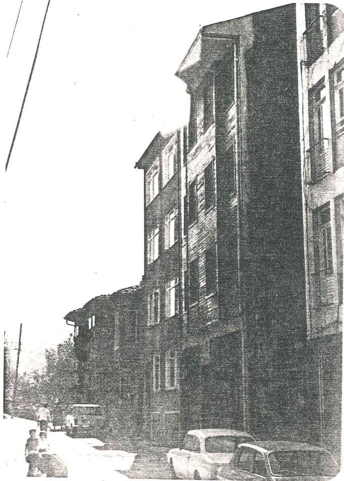
Resim 39- Yenigün Sokakta kötü bir restorasyon geçirerek apartmanlaşmış bir ev
