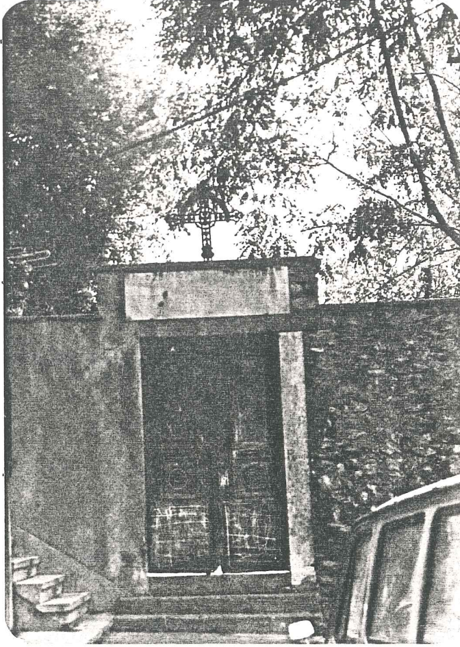
Resim 48- Rum Ortodoks Kilisesi giriş kapısı ve duvarı
