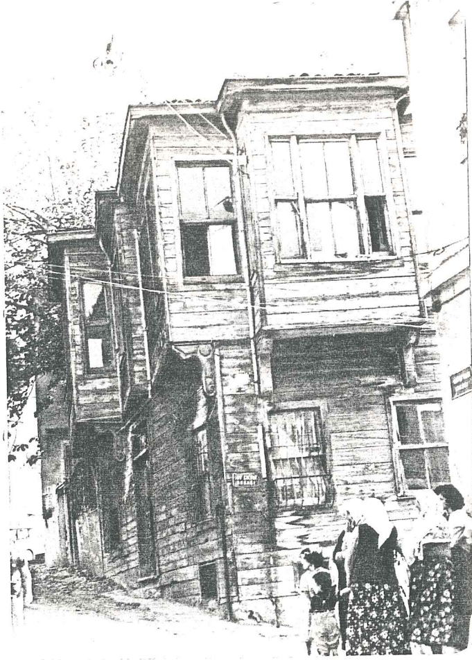
Resim 52- Yatayda "y" açıklığı çıkma yan cephe pen- ceresi
