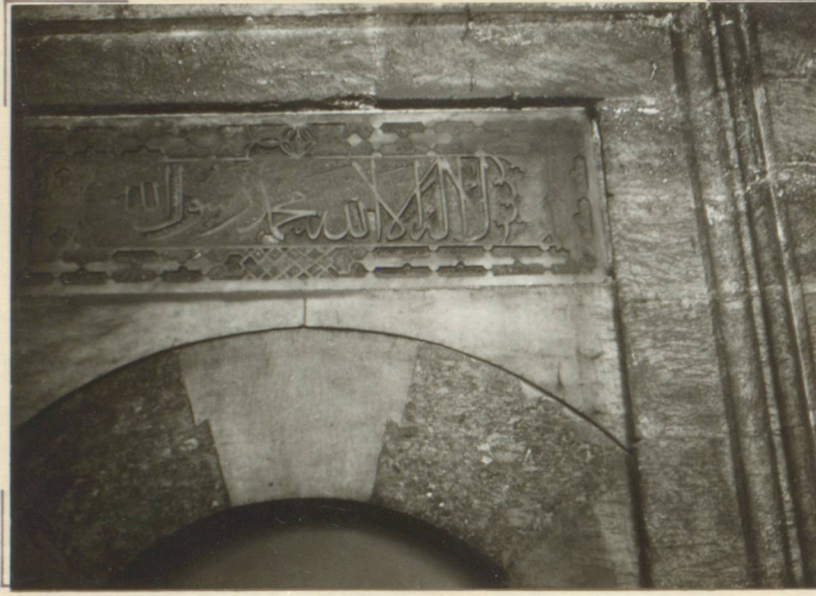
106 A - İSKELE MİHRİMAH SULTAN Cami sol minare giriş kapısı üzerindeki kakma tekniğindeki mozaik kitabe.
