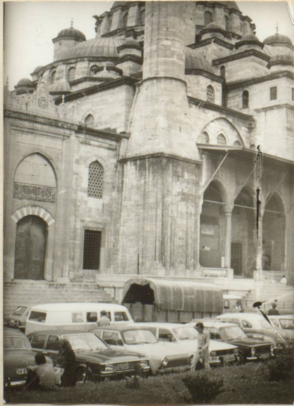
Yenicami saġ minare kaide görünüşü (R.31)
