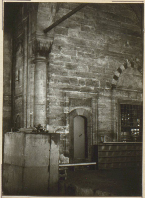
106- İSKELE MİHRİMAH SULTAN Cami sol minare kaidesi
