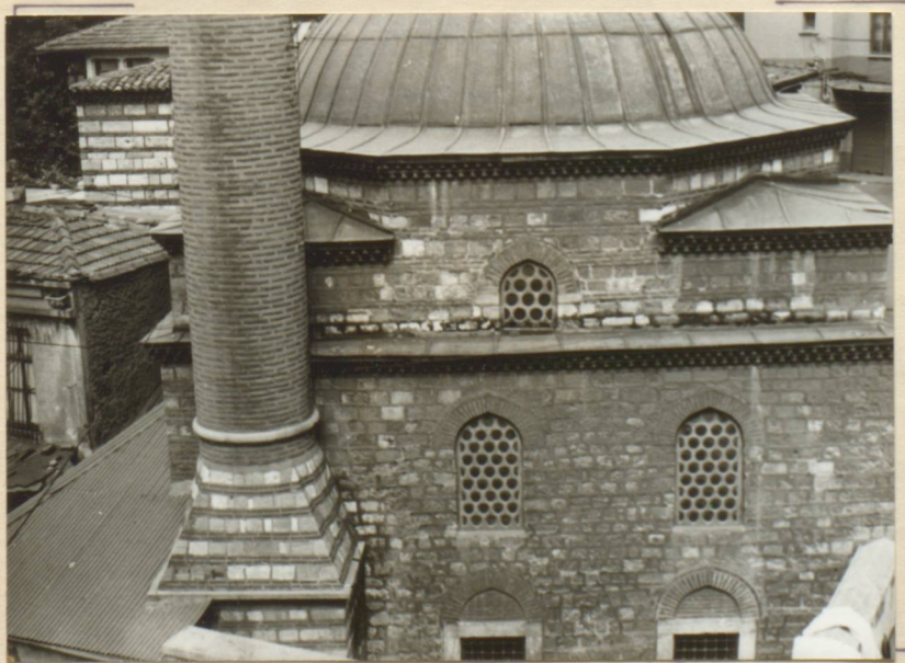
118 - ALI PAŞA Cami minare kaidesi
