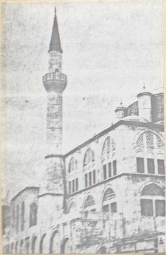
79- MESİH PAŞA Cami minare kaidesi
