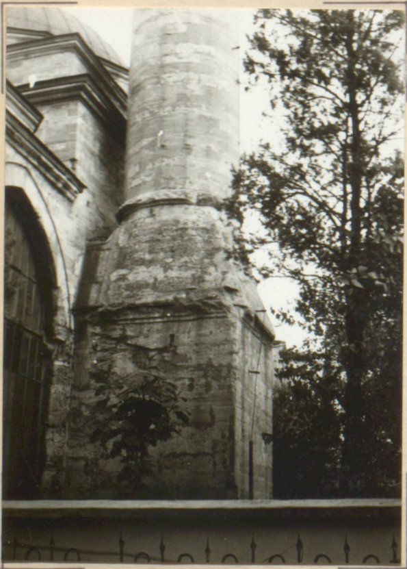
121 İSKENDER PAŞA Cami minare kaidesi
