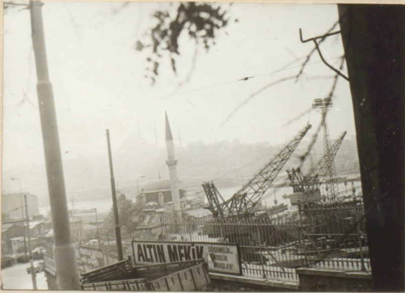
Sokullu cami minare kaide görünüşü (R.49)
