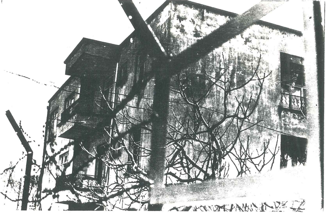
Fotoğraf: 18 - Ahşap evlerin yerine yapılan betonarme bir konut.
