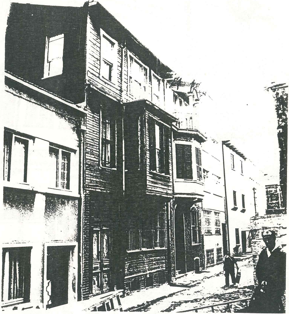
RESİM 120- Gülmez Hasan sok. 591 ada, 3-4 parsellerdeki ahşap evlerin görünüşü 5 no.lu parsel eski eser niteliğinde ahşap yapı olarak tesbiti yapılmasına rağmen resimde görüldüğü gibi yıkılıp yerine yeni bina yapılmıştır.
