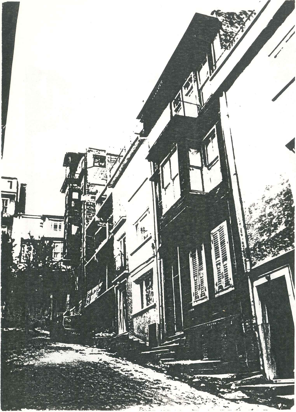
RESİM 115- Hacet sok. 590 ada, 14-1 parsellerdeki ahşap evlerin görünüşü. 16 parselde bulunan ahşap yapı korunması gerekli eski eser olmasına rağmen yıkılıp yeni inşaat yapılmak istenmişse de Belediye tarafından durdurulmuştur.
