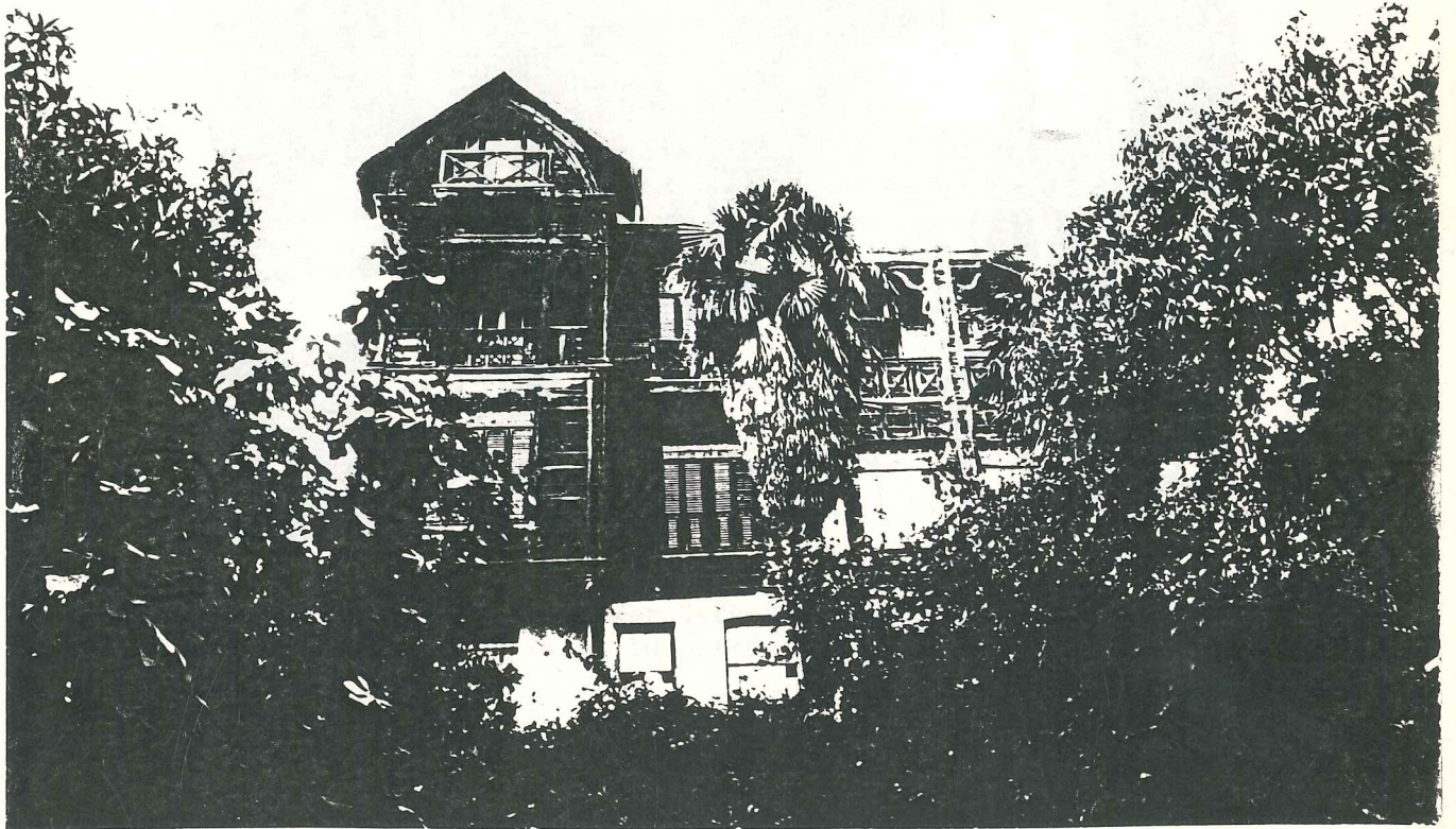
RESİM 77- Set üstündeki ahşap konakların görünüşü, 590 ada, 2-3 parsel
