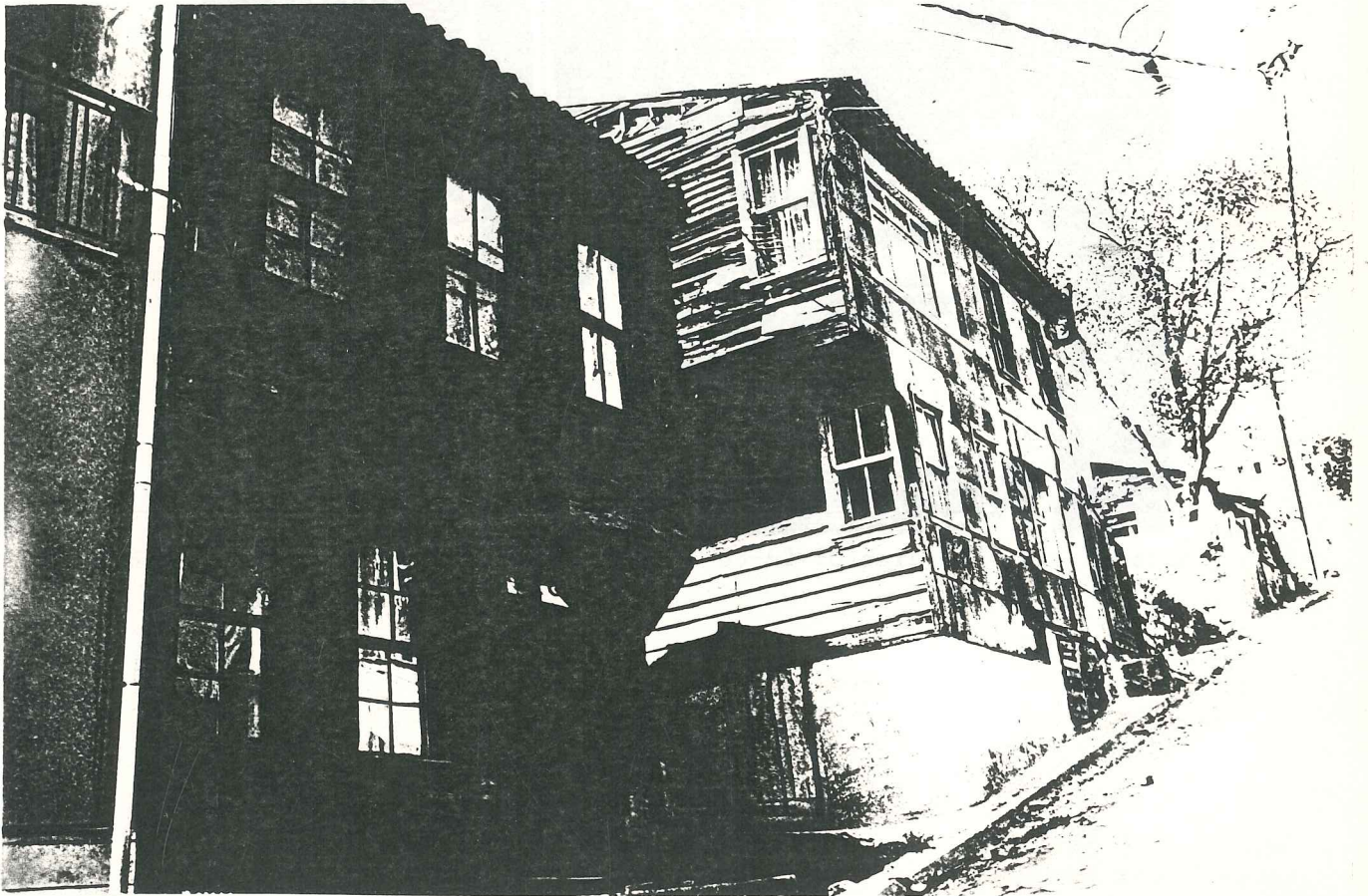
RESİM 95- Dede Yusuf sok. 546 ada, 8-7 parsellerin görünüşü
