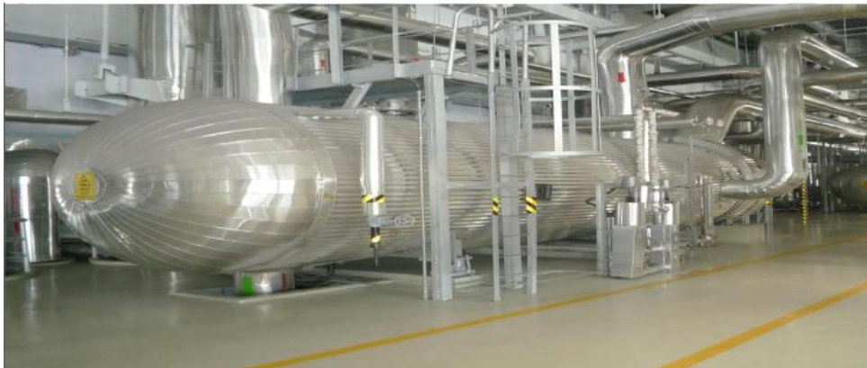
Şekil 2. 5 Yüksek Basınç Besleme Suyu Isıtıcısı[22]
