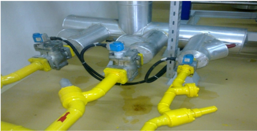
Şekil 4.9 Tesisteki üç adet genleşme valfinin fotoğrafı
