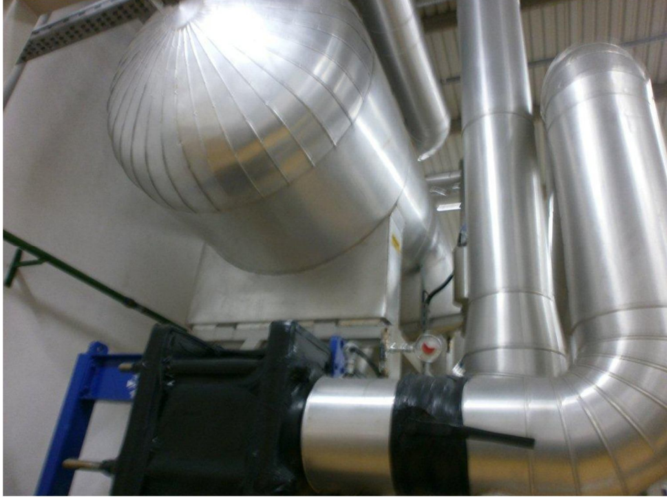
Şekil 4.13 Ayırıcı tankın fotoğrafı
