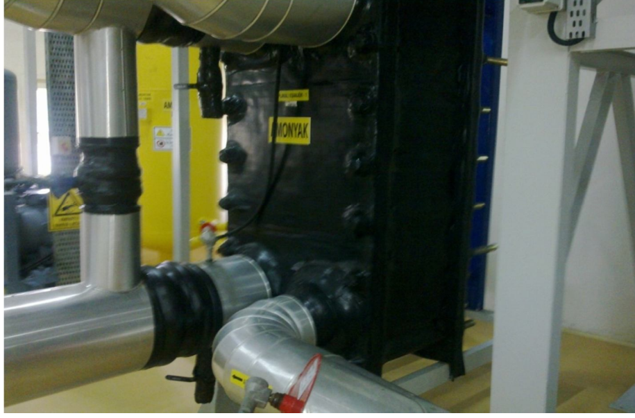
Şekil 4.8 Tesiste yer alan iki evaporatörden birinin çekilmiş fotoğrafı
