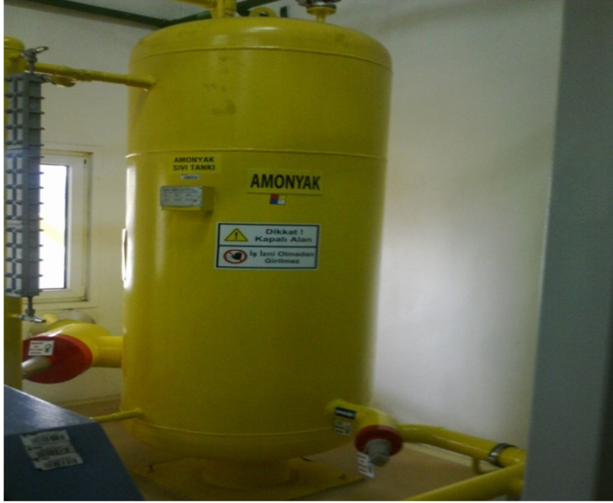
Şekil 4.15 Sıvı tankının fotoğrafı
