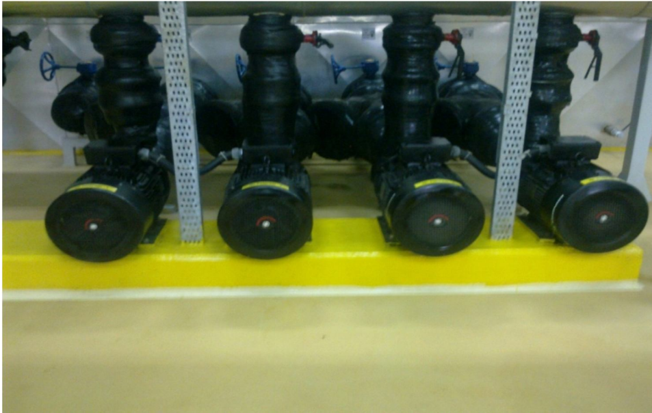
Şekil 4.11 Tüketime giden hatta yer alan dört pompanın fotoğrafı
