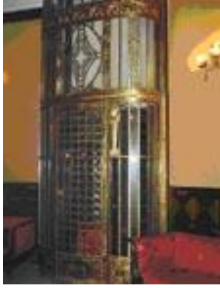
Şekil 2.5 Hidiv Kasrı'nda buhar gücü ile çalışan asansör [10]
