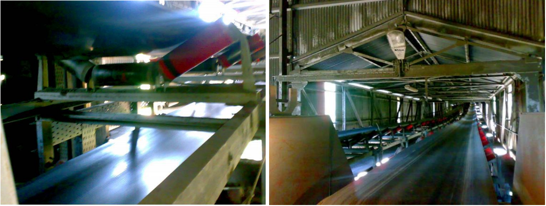
Şekil 0.7 Bant tüneli ve 3'lü istasyonlu konveyör
