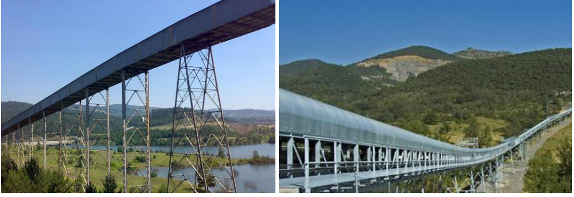
a. Çoklu konstrüksiyon kapama
