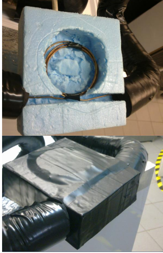
Şekil 3. 7 Kapileri boru yalıtım kabı yerleşimi ve yalıtım kabı kapatılmış şekli
