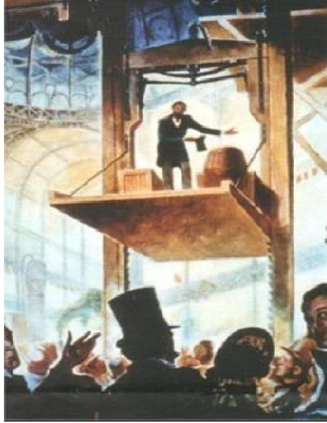
Şekil 2.4 Elisha G. Otis'in Crystal Palace'da Yaptığı Güvenlik Deneyi (İmrak ve Gerdemeli, 2000)
