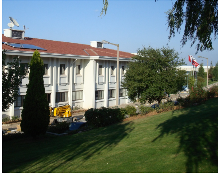
Şekil 6.2: Arçelik-LG PV sistemi ve çevre yapısı
