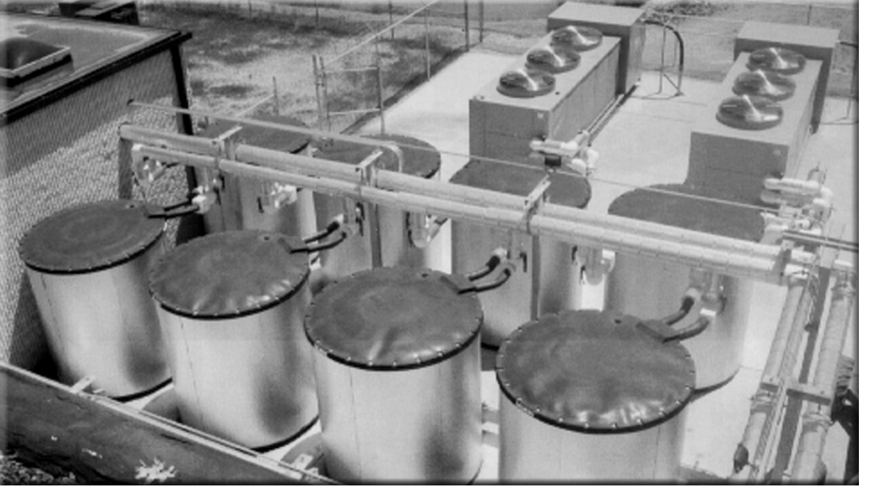
Şekil 2.5 Modüler boru üzeri buz depolama tankları (kondenserleriyle birlikte)
