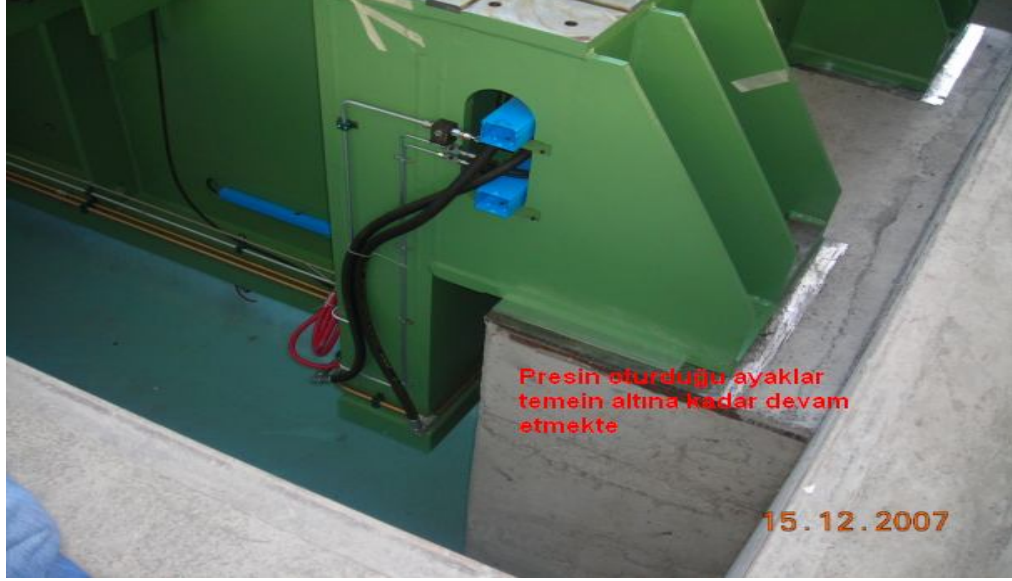
Şekil 4.16 Presin temel içine yerleştirilmesi
