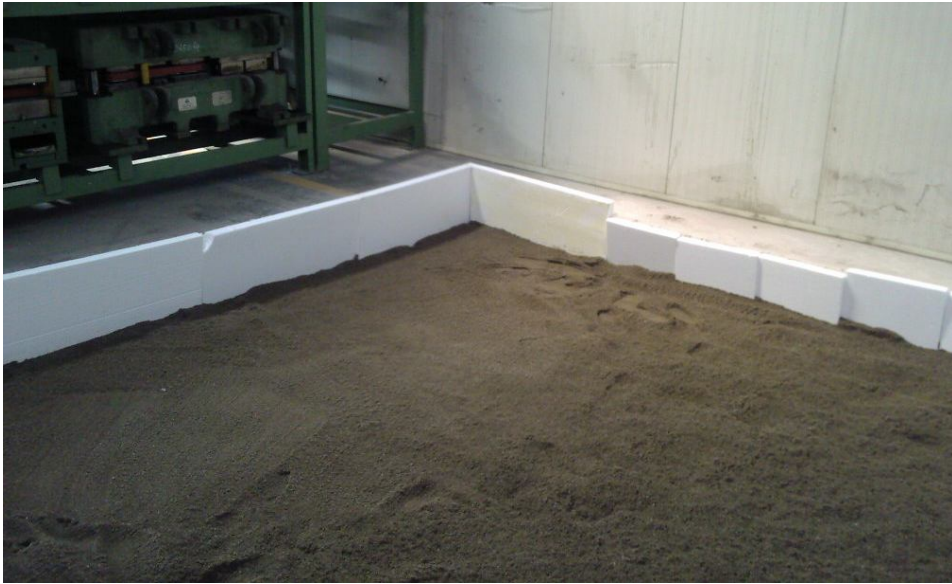
Şekil 4.13 Pres temeli ile fabrika temeli ayrımı
