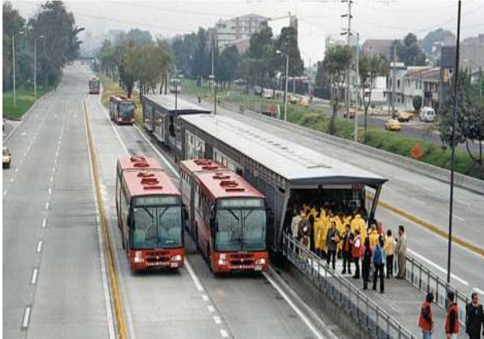
Şekil 5.3: Quito Ecovia (Ekvator) Fiziksel Engellerle Ayrılmış Metroleybüs Yolu
